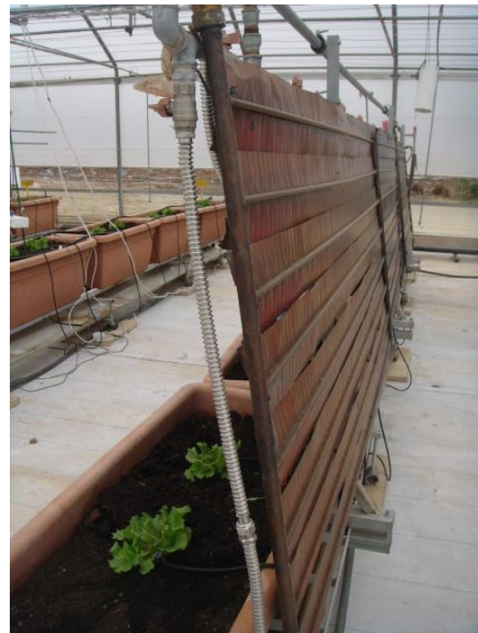
Figura 24. Sistema di distribuzione del freddo/caldo denominato “piastre”.
