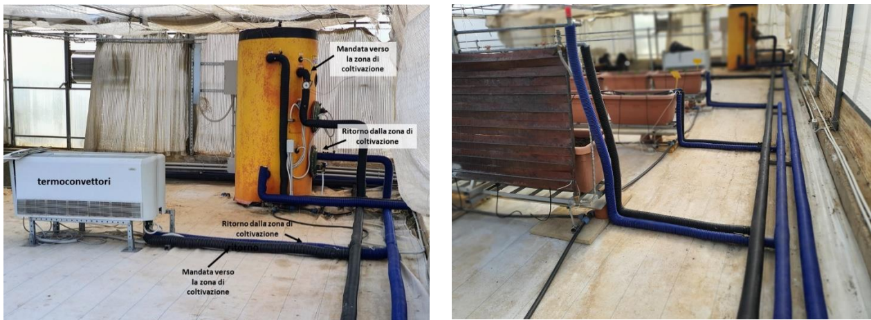
Figura 22. Tubazioni di mandata (colore nero) e ritorno (colore blu) all'interno della serra.
