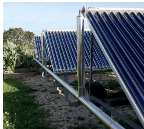
Figura 20. Coibentazione dei tubi di distribuzione in prossimità del campo solare nel 2015 e 2020.
