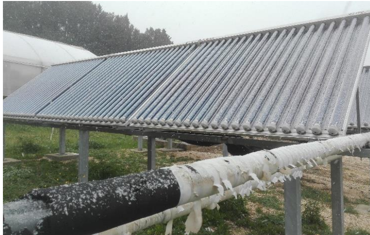
Figura 19. Lesioni della guaina isolante in elastomero di colore nero e del nastro adesivo bianco (2018).
