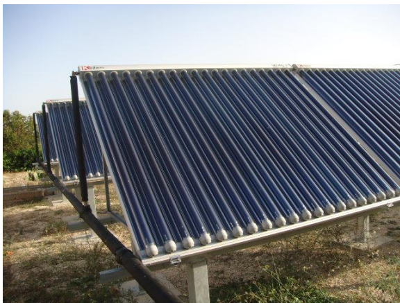
Figura 20. Coibentazione dei tubi di distribuzione in prossimità del campo solare nel 2015 e 2020.
