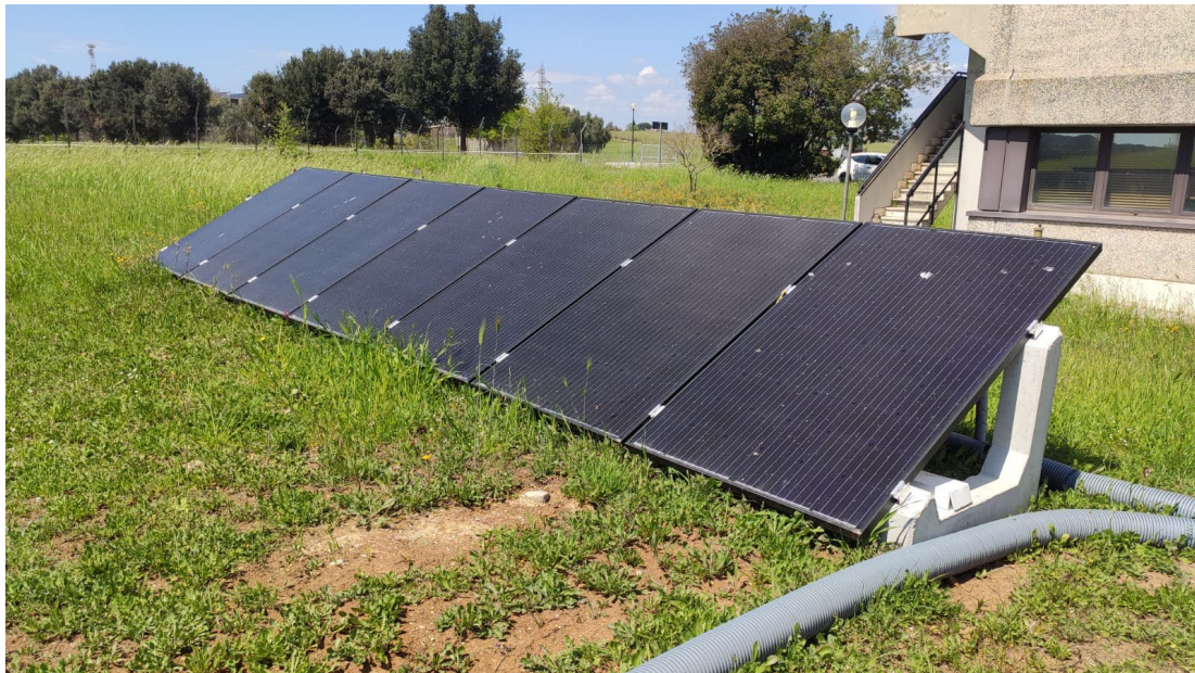
Figura 95: Installazione dei 7 moduli fototermici nel terrapieno prospiciente l'edificio F83
