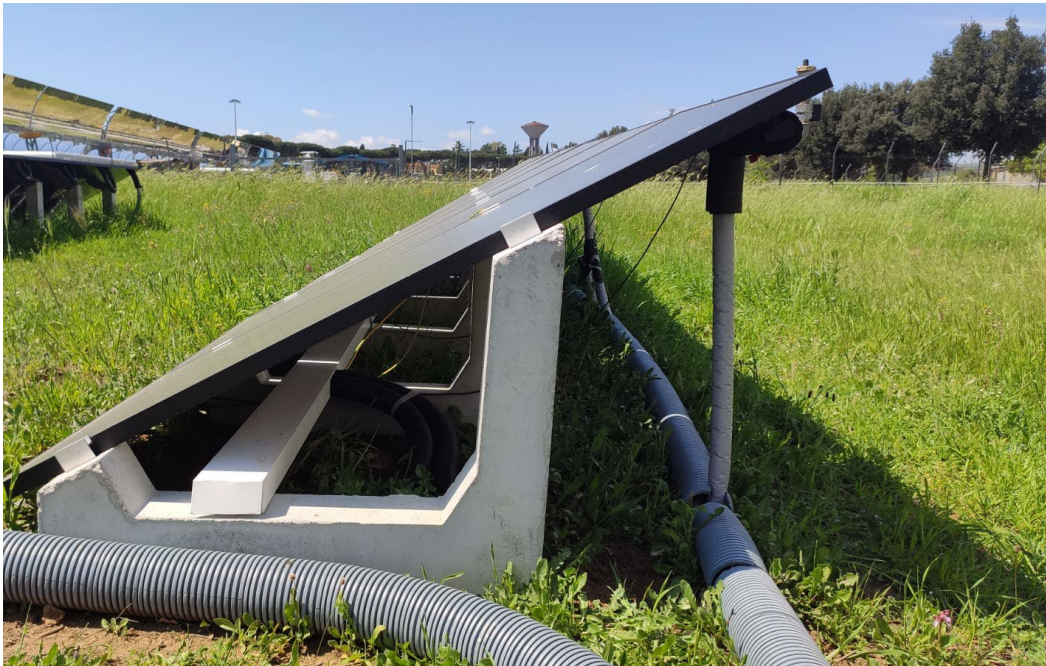
Figura 98: dettagli della posa dei moduli PVT e della connessione al circuito termico
