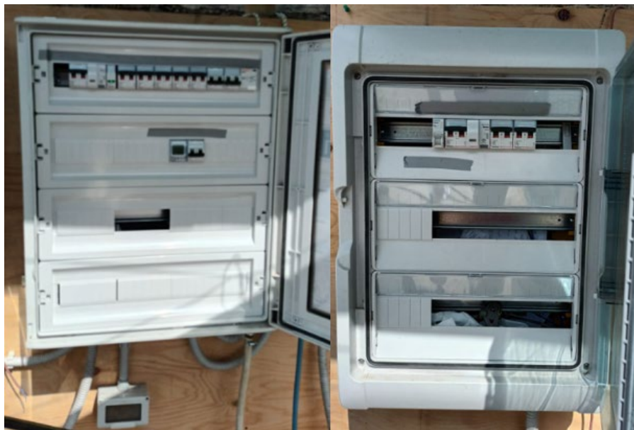
Figura 133: installazione quadri elettrici per l'alimentazione e il sezionamento dei singoli componenti d'impianto
