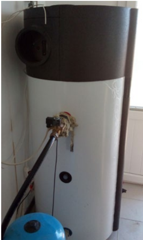
Figura 5: Pompa di calore per ACS – installazione elettrovalvola e sensore termico PT500 nella condotta di mandata dell’acqua calda sanitaria
