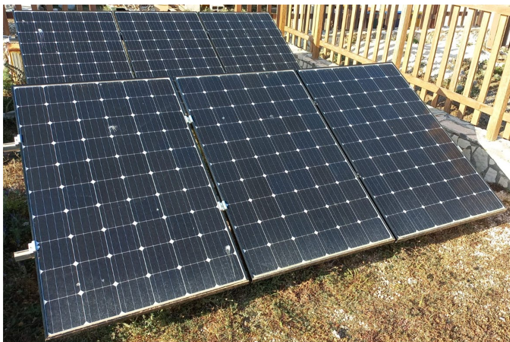
Figura 2: Campo fotovoltaico del sistema ibrido sperimentale di Lampedusa - 6 moduli da 290 Wp ciascuno connessi in 3 stringhe da due moduli ciascuno
