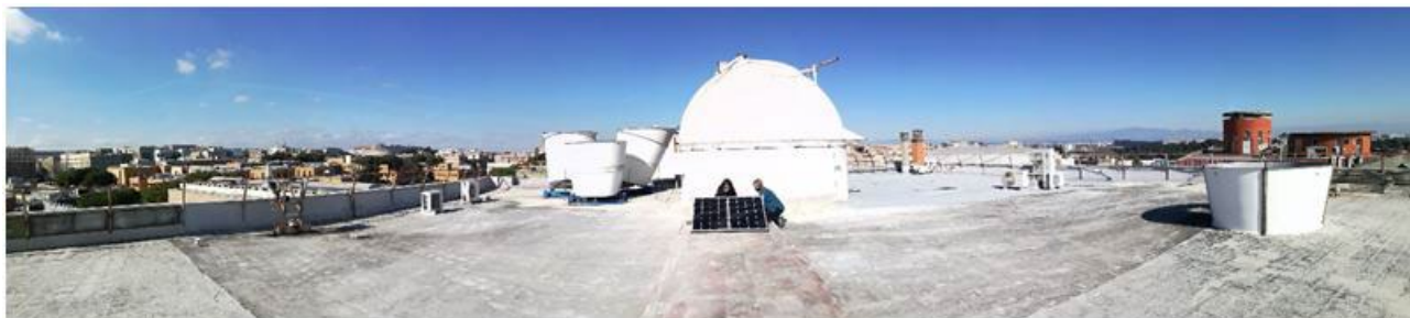
Figura 179: Foto panoramica del tetto del Dipartimento di Fisica dell’Università. I pannelli oggetto della sperimentazione sono installati a sud della cupola, ed hanno l’orizzonte privo da ostacoli per buona parte della giornata.
