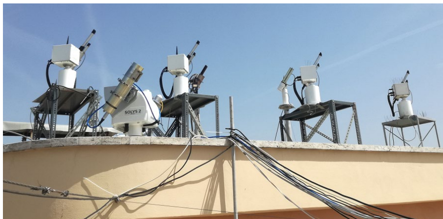
Figura 178: Fotometri solari installati sul tetto del Dipartimento di Fisica dell'Università Sapienza durante una campagna di intercalibrazione del 2019
