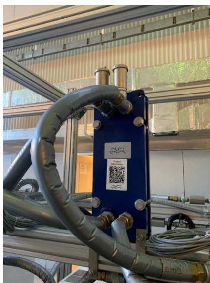
Figura 15. Scambiatore di calore a piastre (M3-FG) presente in ciascuna sottostazione di scambio delle pompe di calore delle utenze.
