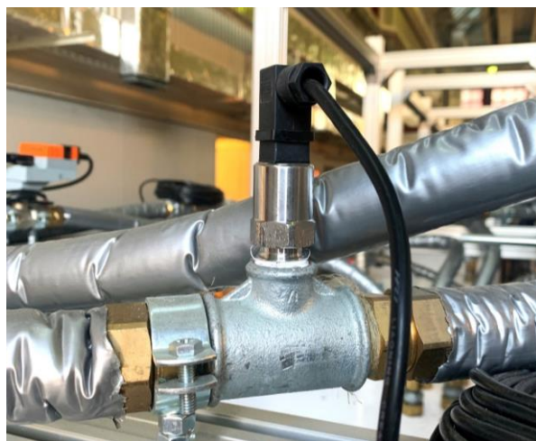
Figura 28. Trasduttore di pressione piezoresistivo.
