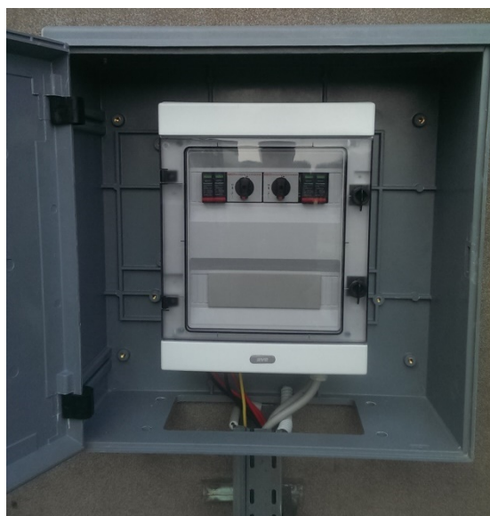
Figura 21. I Quadri di campo QCAM1 e QCAM2
