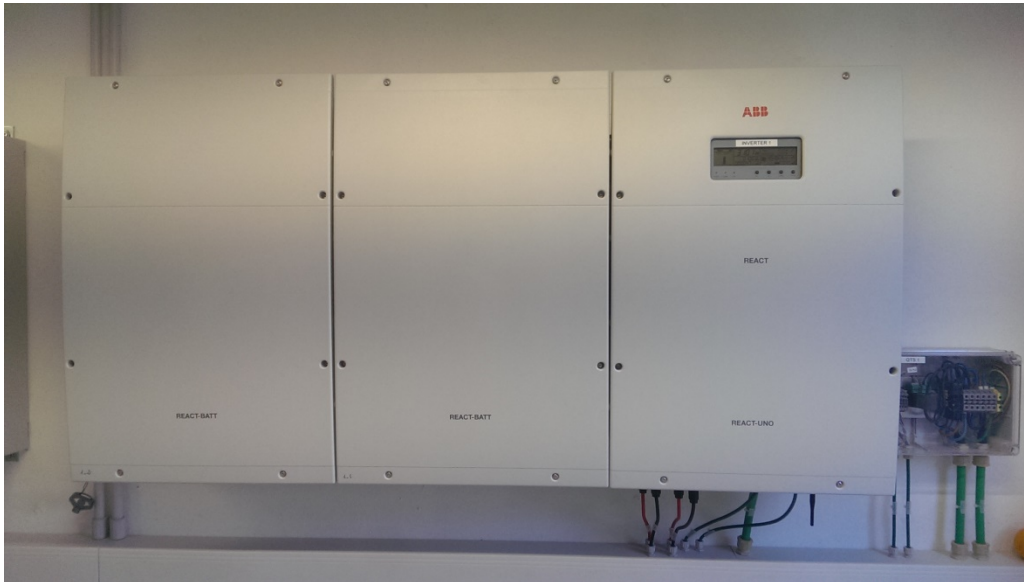
Figura 24. L'inverter fotovoltaico e il sistema di accumulo ABB REACT (unità sulla fase L1)
