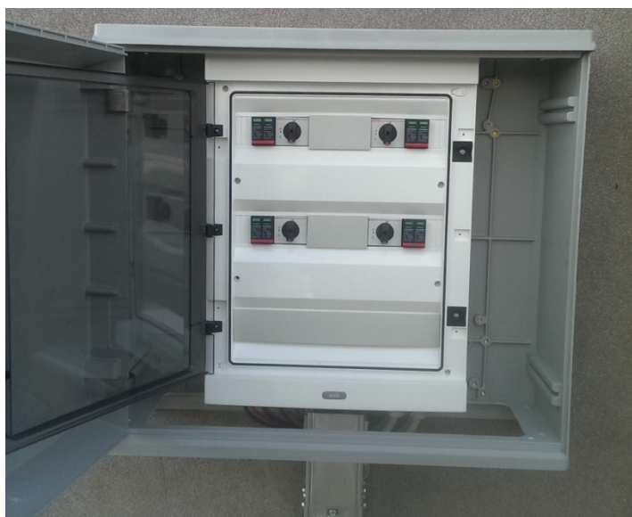
Figura 21. I Quadri di campo QCAM1 e QCAM2
