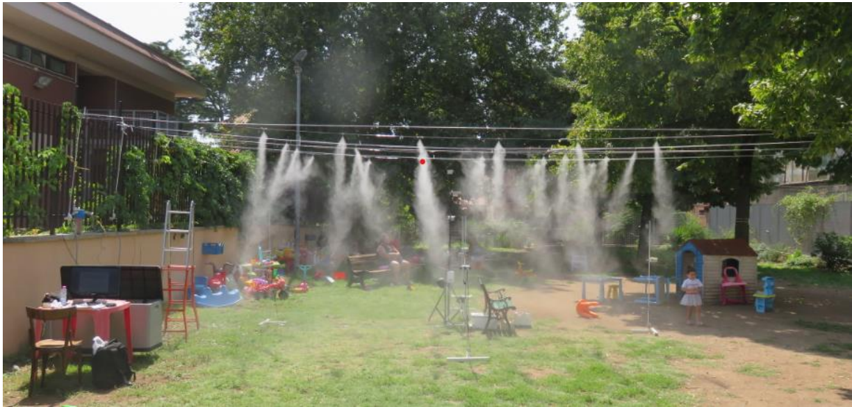
Figura 55. Sistema evaporativo montato su fili testati di alluminio
