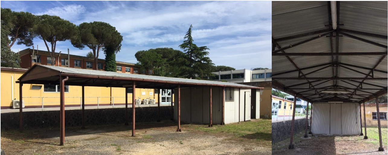
Figura 59. Infrastruttura per installazione impianto evaporativo
