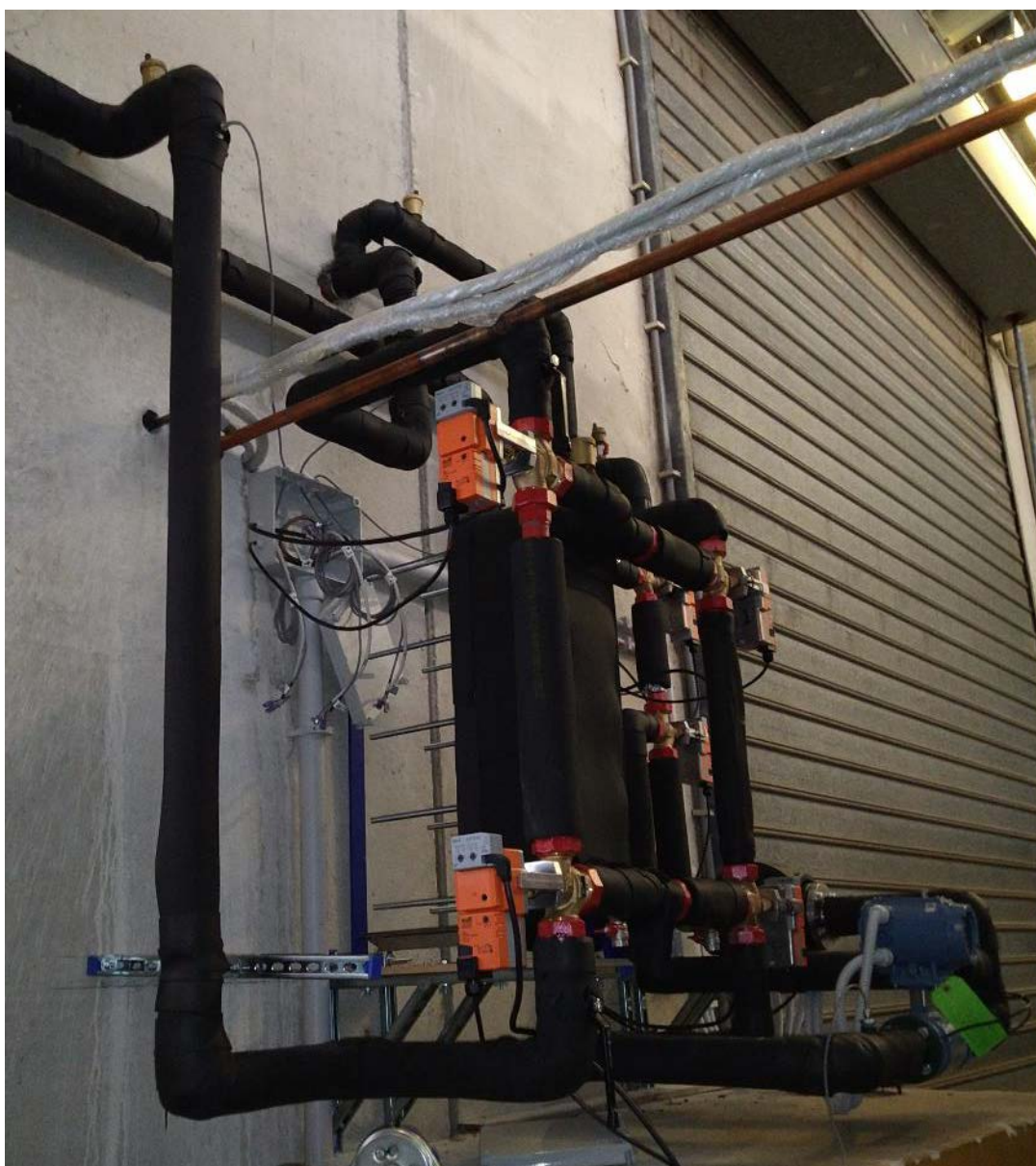
Figura 139 – Impianto coibentato al termine dell’installazione
