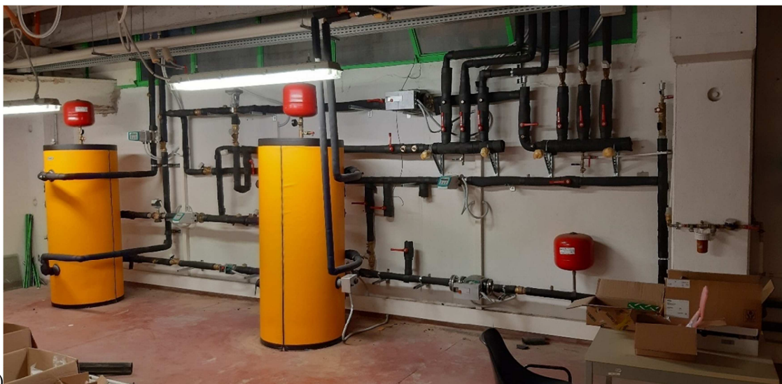
Figura 3. a) Aerotermi interni alla camera climatica; b) sezione di umidificazione ad elettrodi immersi; c) circuito idronico a servizio della camera climatica.
