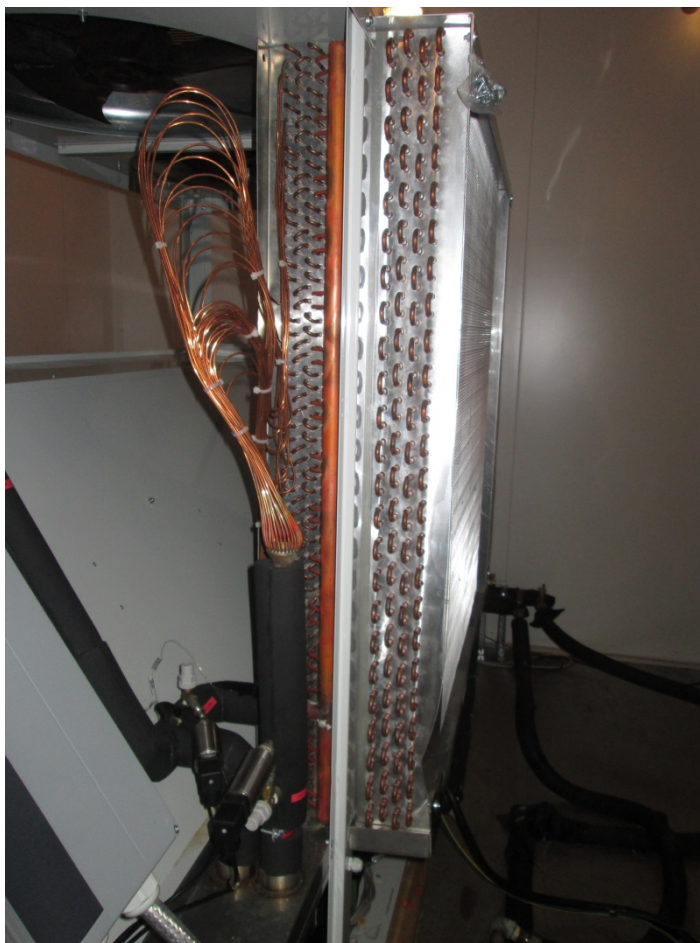
Figura 8 – Doppia batteria alettata gas-cooler / evaporatore
