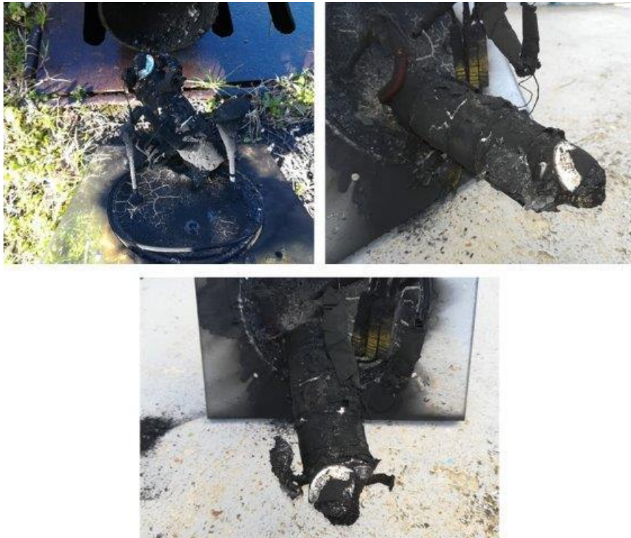
Figura 41 Residuo della cella dopo il thermal runaway
