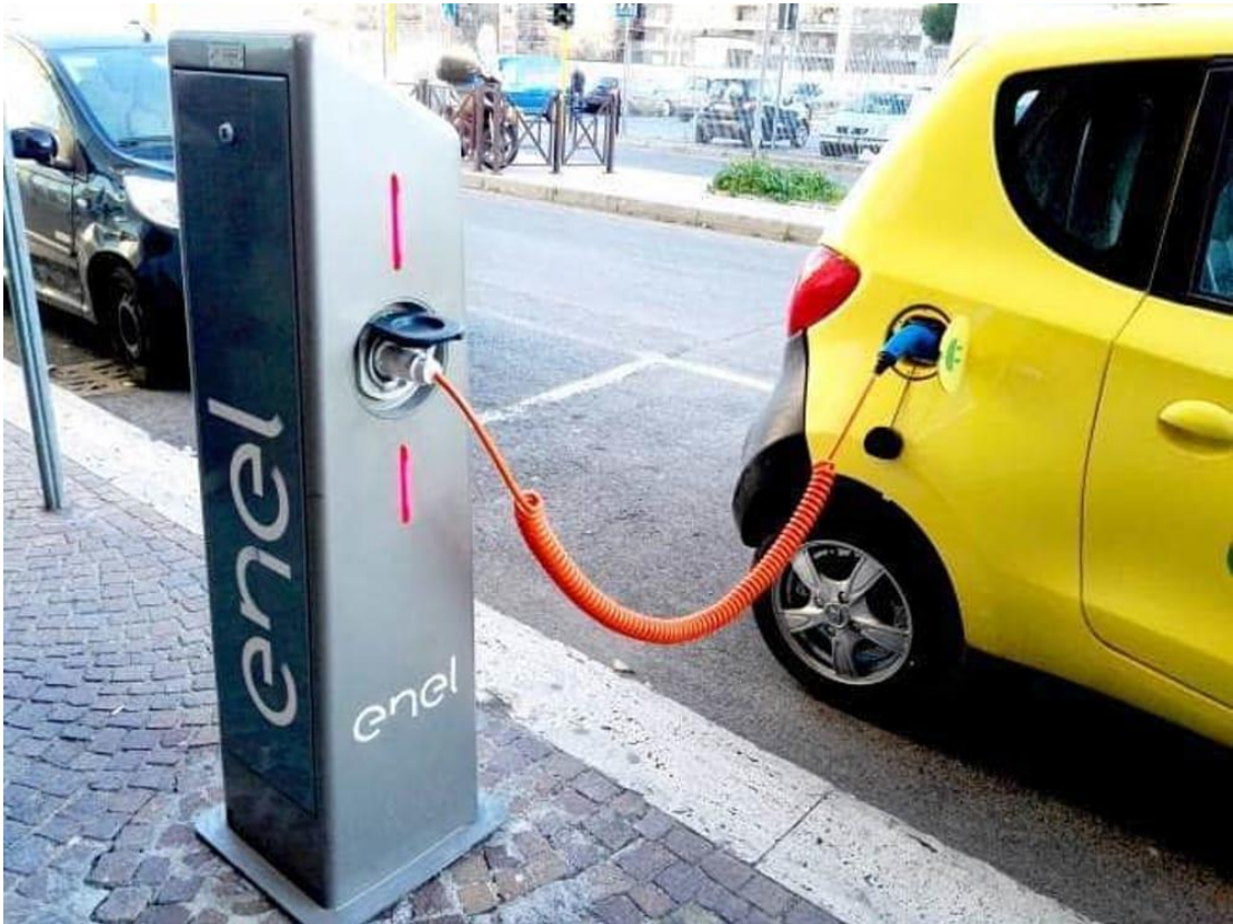
Figura 10: Colonnina di ricarica pubblica di tipo conduttivo
