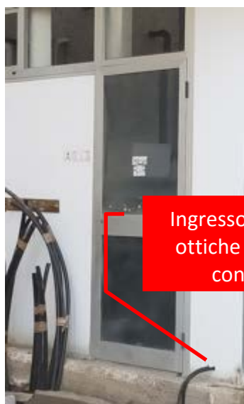
Figura 16. Sonde geotermiche e corrugato contenente la fibra ottica raccordati nei cavedi orizzontali fino al sito prescelto del collettore, adiacente la sala controllo
