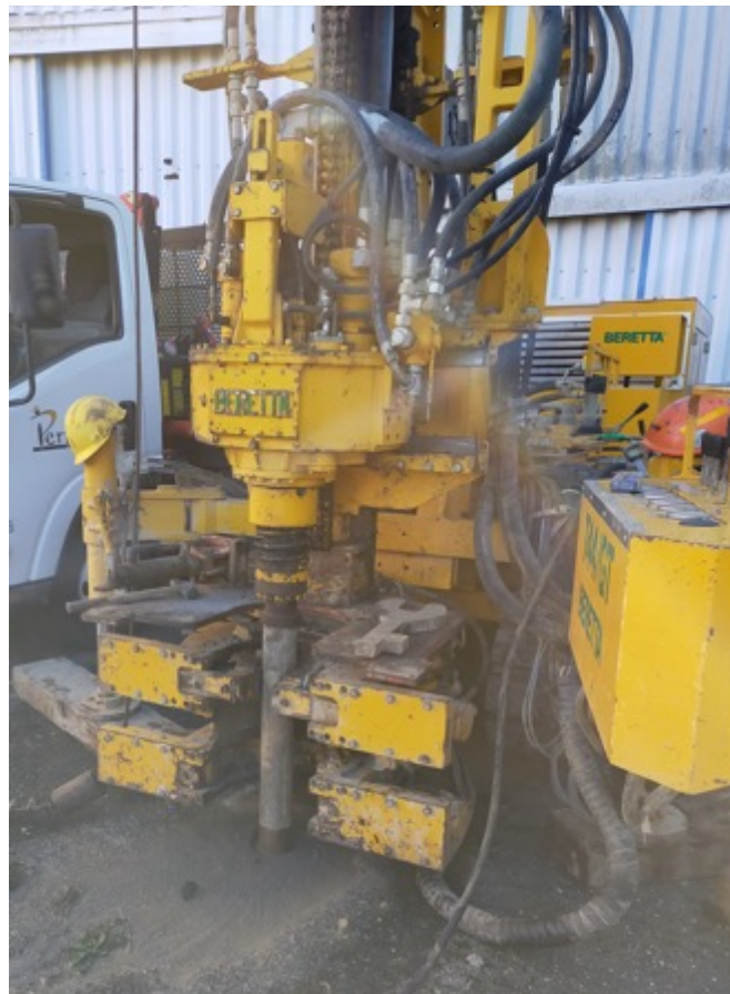
Figura 6. Avanzamento delle aste di perforazione fino a fine corsa, coppia di ganasce per il blocco delle aste
