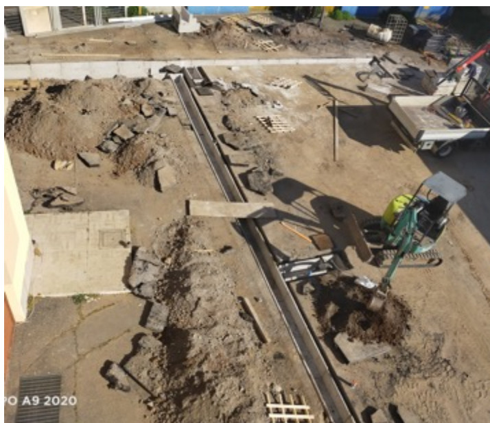
Figura 17. Vista dall'alto campo geosonde
