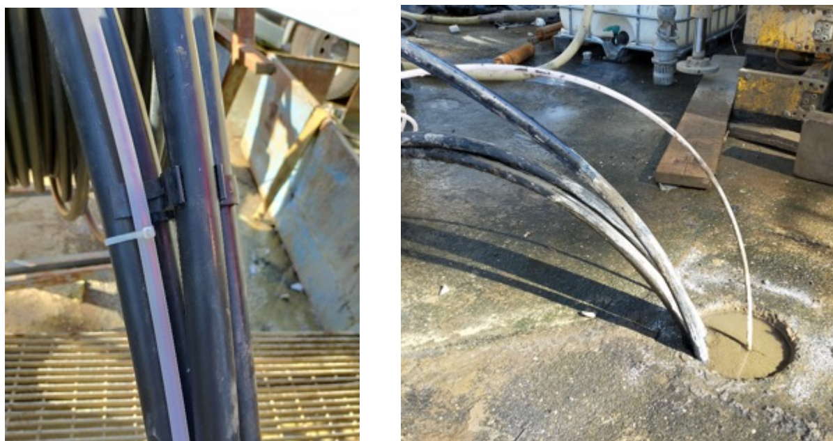
Figura 38. Assemblaggio del tubicino contenente la fibra ottica alle sonde geotermiche nel pozzo geotermico
