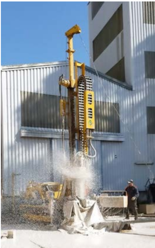
Figura 11. Perforazione ad aria compressa miscelata a schiumogeno e martello fondo foro
