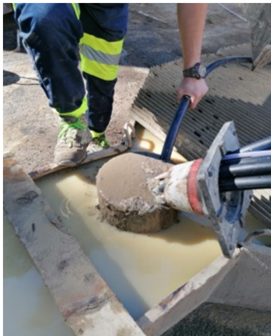
Figura 14. Cementazione del foro con malta cementizia
