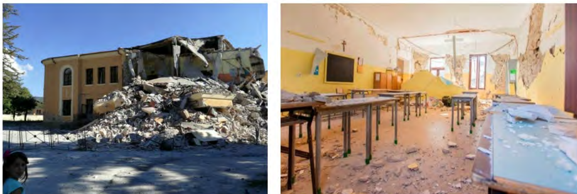
Figura 2. Il crollo della scuola di Amatrice a seguito del terremoto del 24 agosto 2016
