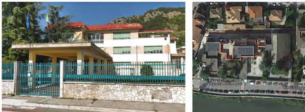
Figura 73. Facciata (sinistra) ed inquadramento territoriale (destra) dell'edificio caso studio
