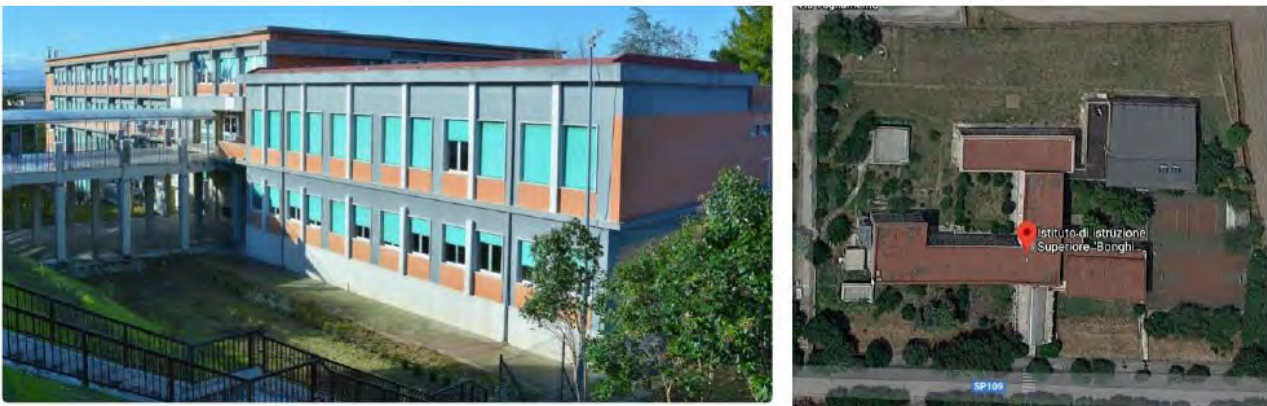
Figura 41. Facciata (sinistra) ed inquadramento territoriale (destra) dell'edificio caso studio
