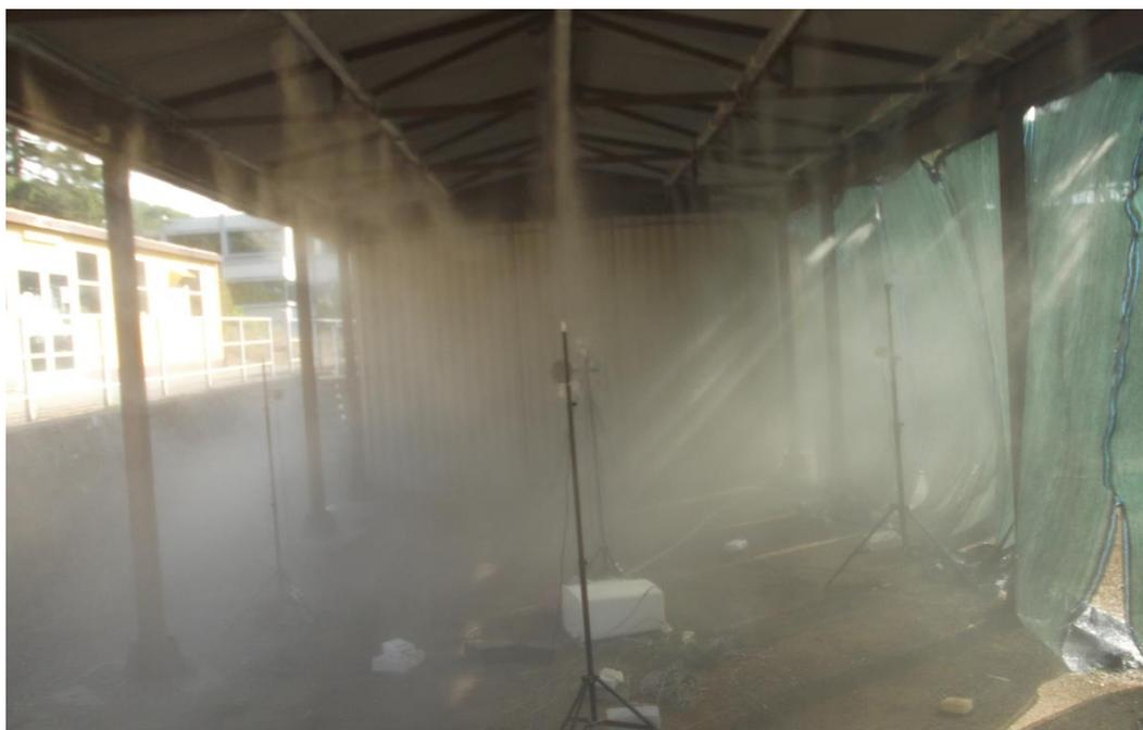
**Figura 31. Impianto evaporativo nel mese di settembre con schermo laterale in funzione.**
