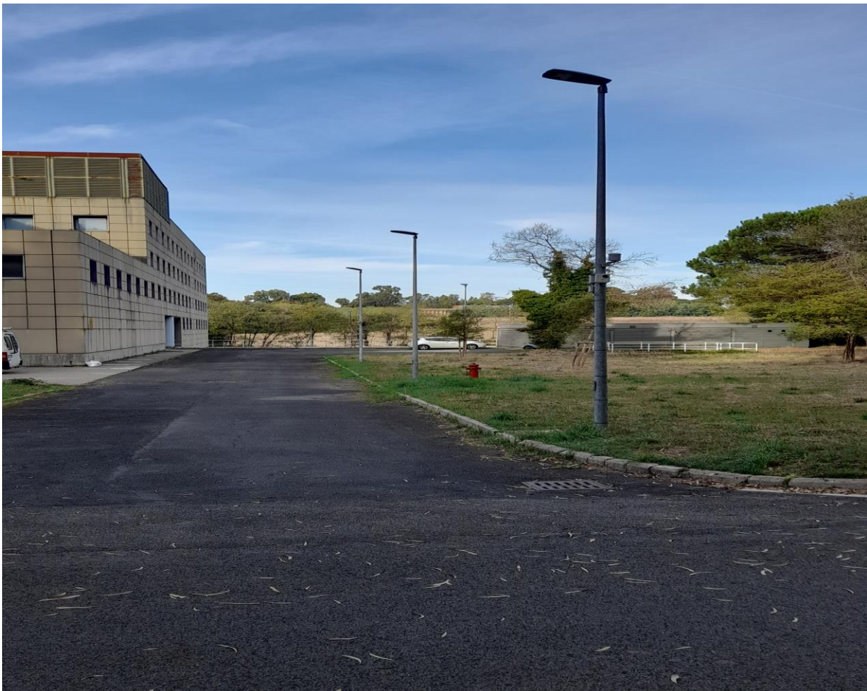
Figura 13 – Particolare della smart road
