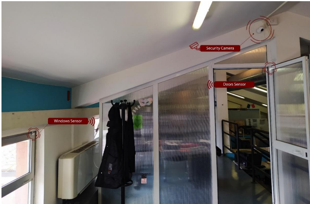
Figura 19. Sensori di apertura porte e finestre e dispositivi di sicurezza
