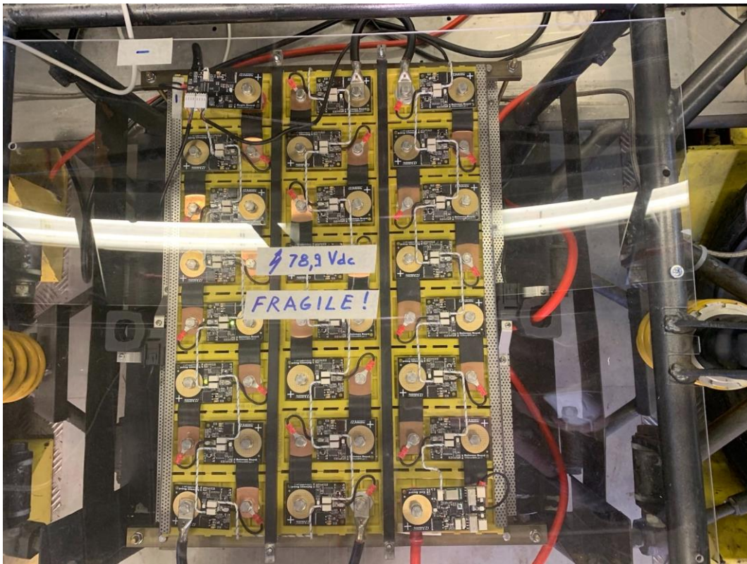
Figura 15 - Pacco batterie del veicolo elettrico URBE
