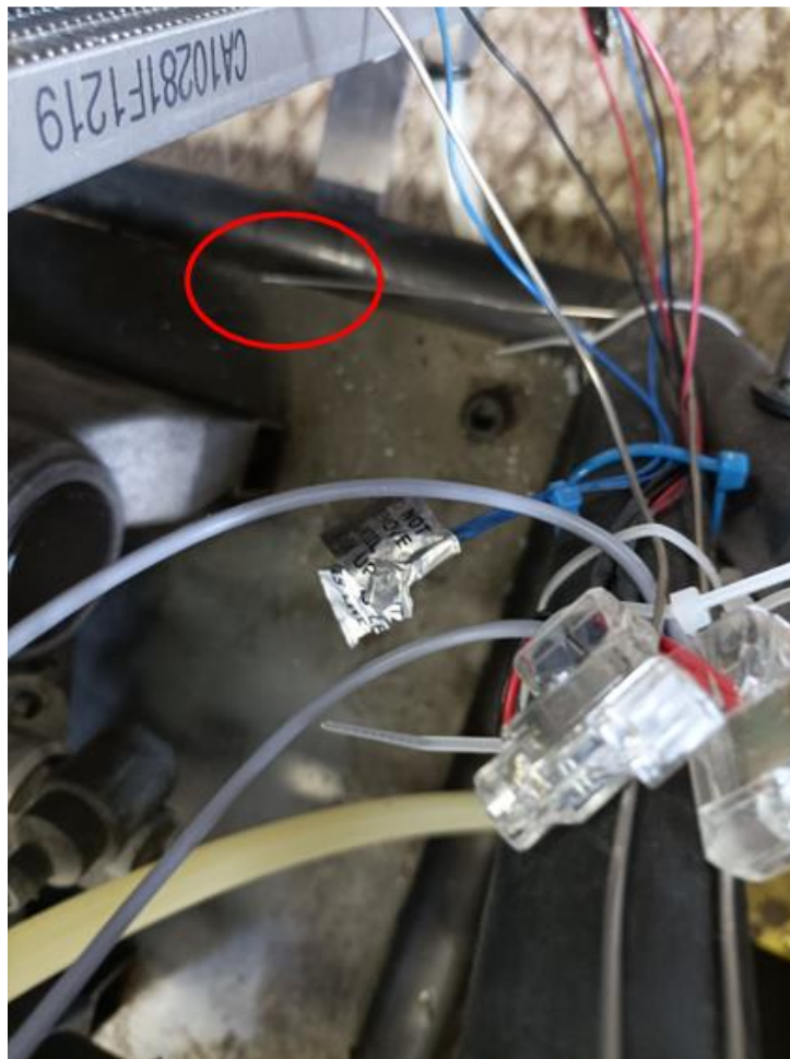
Figura 57. Particolare del posizionamento di una termocoppia
