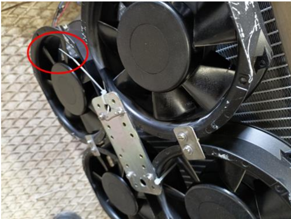
Figura 56. Particolare del posizionamento di una termocoppia
