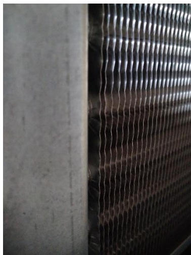
Figura 7.1. Batteria alettata Frigo System® CCV1470/4-T7.
