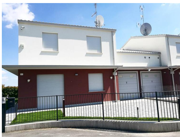
Figura 6. Vista frontale dell'edificio
