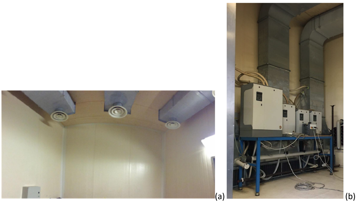
Figura 6. Compensatori (a) ed umidificatori ad elettrodi immersi (b) posti all'interno del calorimetro
