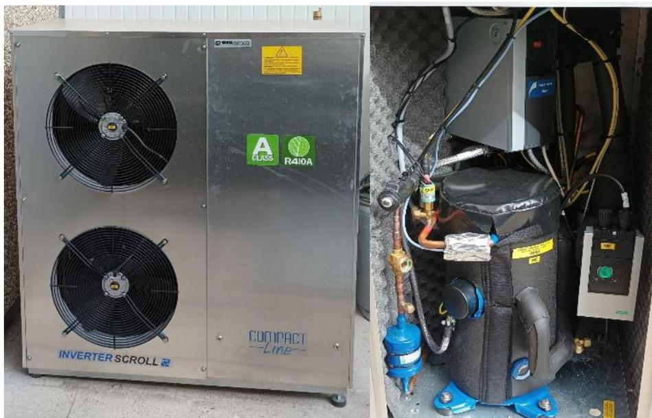
**Figura 26.** Chiller e pompa di circolazione integrata
