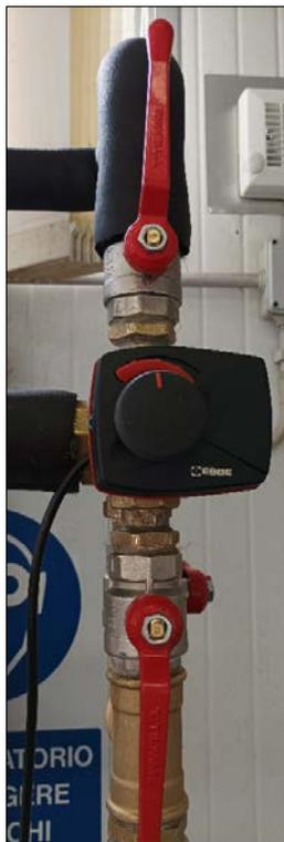
Figura 37. Valvola miscelatrice con attuatore
