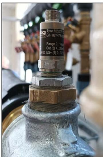
Figura 36. Sensore di pressione
