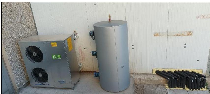
Figura 40. Chiller, serbatoio e collegamento delle sonde geotermiche ai due collettori
