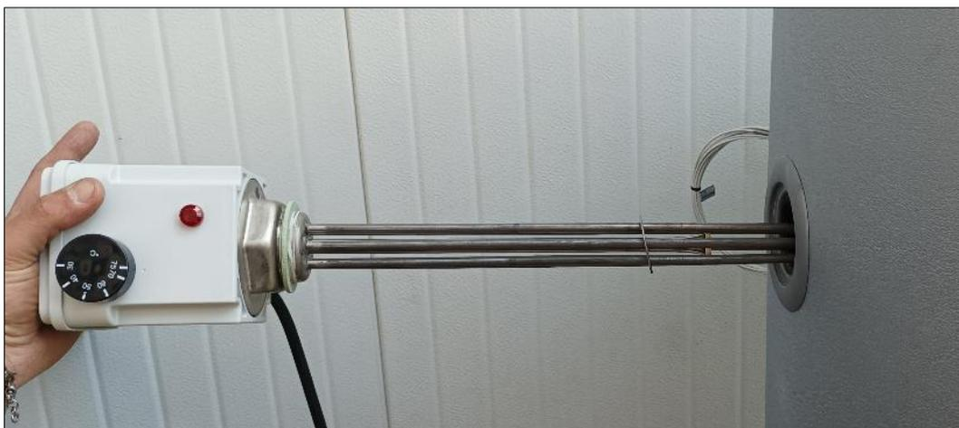
**Figura 31.** Resistenza elettrica inserita nel serbatoio di accumulo
