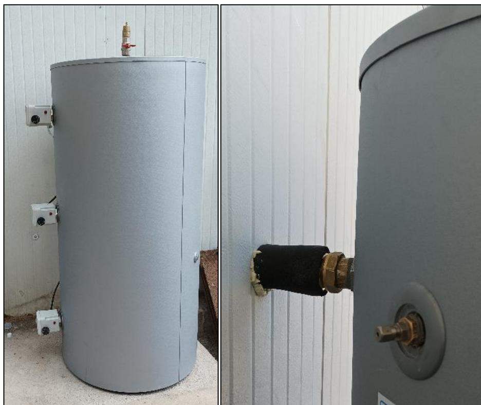
Figura 29. Serbatoio da 500 L installato
