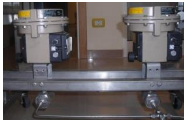
Figura 27. Trasmettitori/regolatori portata gas
