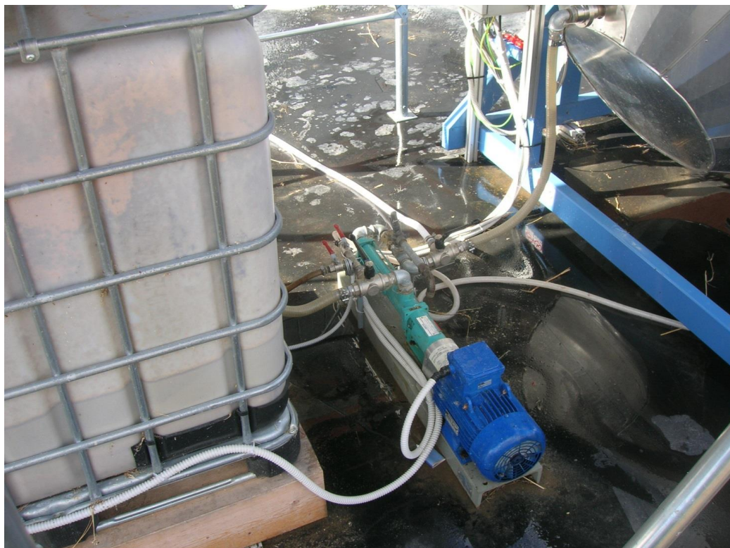
Figura 6. Pompa di alimentazione e sistema di valvole per il caricamento del digestore
