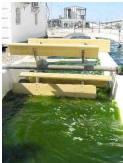
**Figura 3. Sistema di agitazione dell'impianto pilota Seambiotic**
