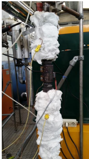
Figura 2. Particolare della linea di campionamento fumi, con il riscaldatore elettrico a fascia ceramica e la coibentazione in lana minerale per alte temperature a monte e a valle del riscaldatore
