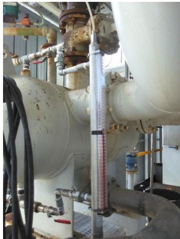
Figura 2.9. Indicatore di livello magnetico dello steam drum
