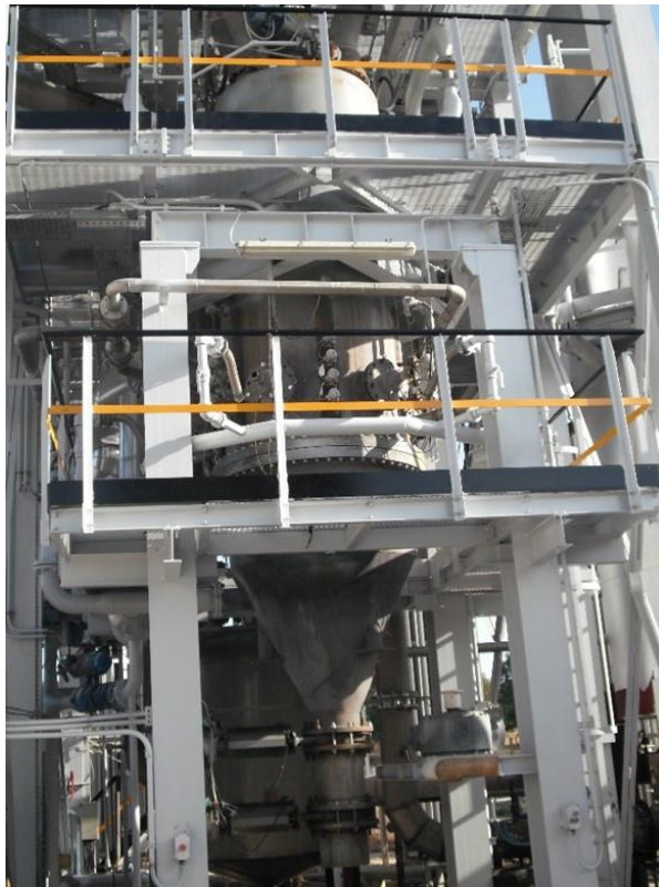
Figura 1.2. Vista frontale de gassificatore dell'impianto dimostrativo
