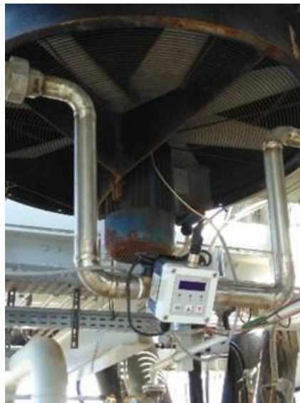
Figura 2.11. Misuratore di portata condense ad ultrasuoni
