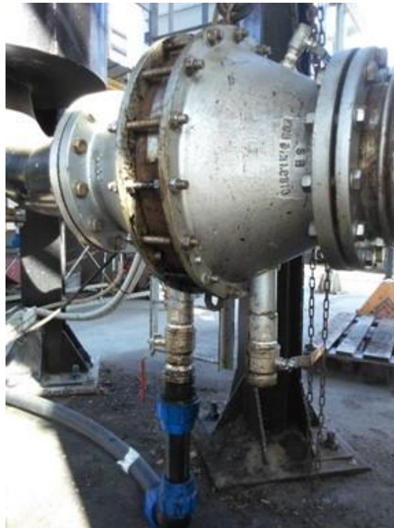
Figura 2.25. Bocchelli di spurgo della valvola rompifiamma
