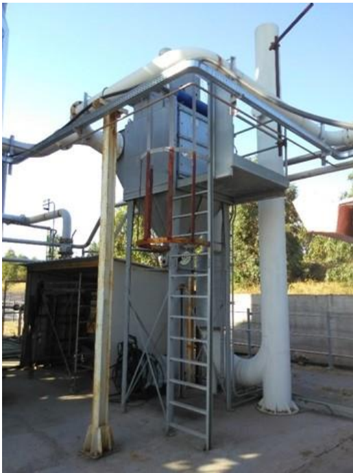
Figura 2.4. Sistema di depolverazione (a sinistra) e dettaglio dei cassettei filtranti (a destra)
