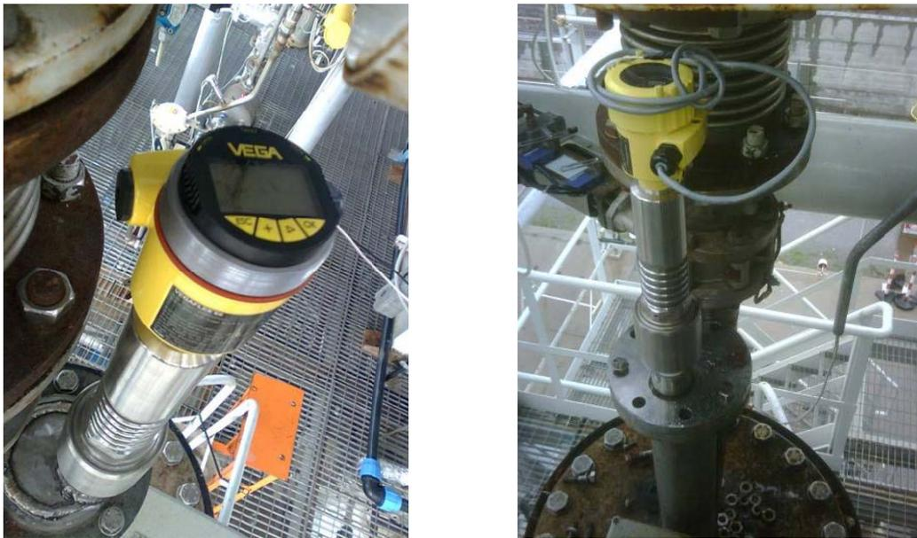
Figura 16 - Vista di dettaglio del misuratore di livello carbone.
