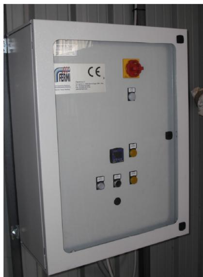
*Figura 2.3.2.2: Quadro di gestione dello scambiatore elettrico preriscaldamento ammine*
