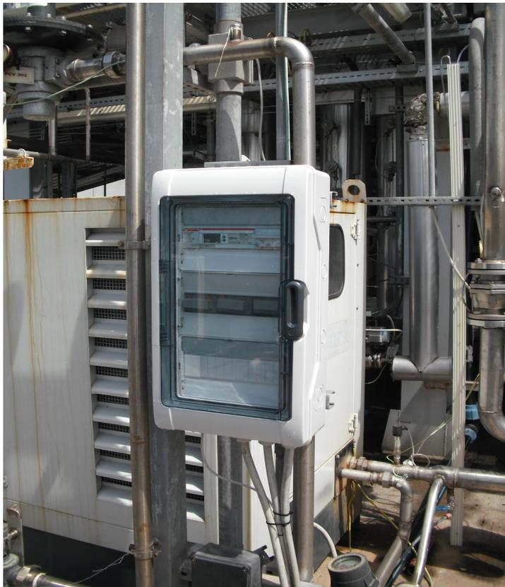
Figura 2.4.2.1: Contatore di kW elettrici prodotti dal motore
