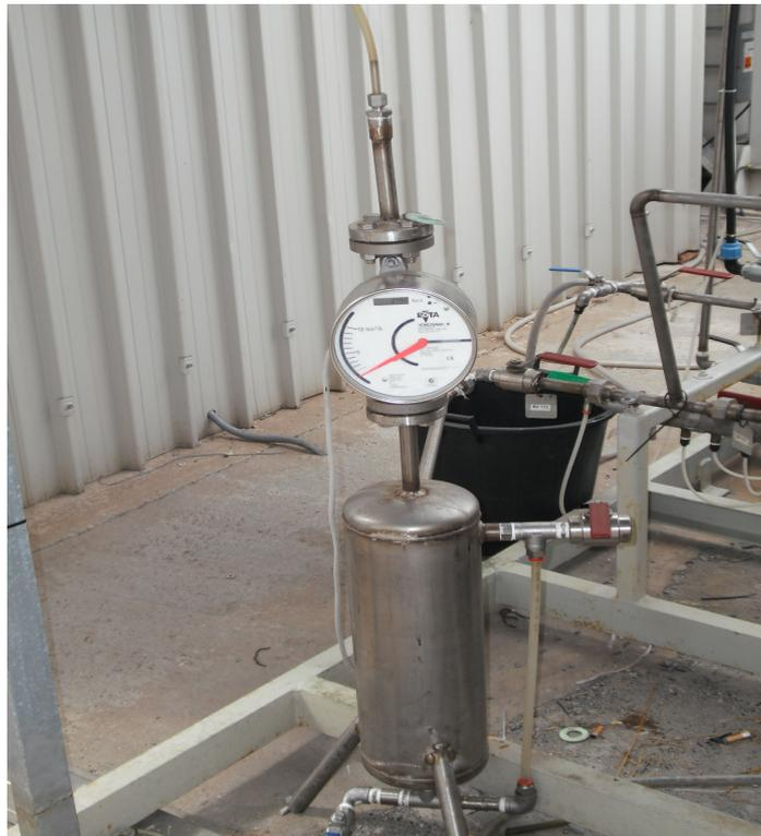
Figura 2.5.1.1: Rotametro misurazione CO<sub>2</sub>
