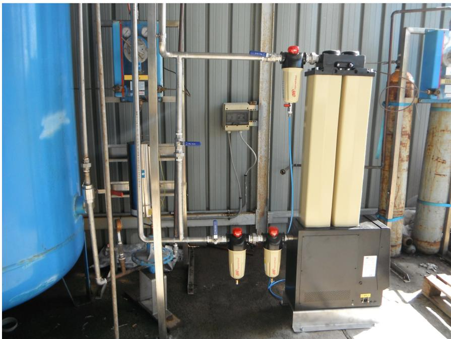
Figura 2.2.1: Sistema di trattamento aria processo
