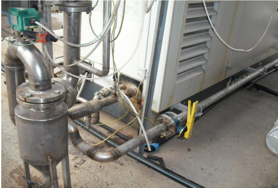
Figura 2.4.1.2: Piping di collegamento gasometro – motore
