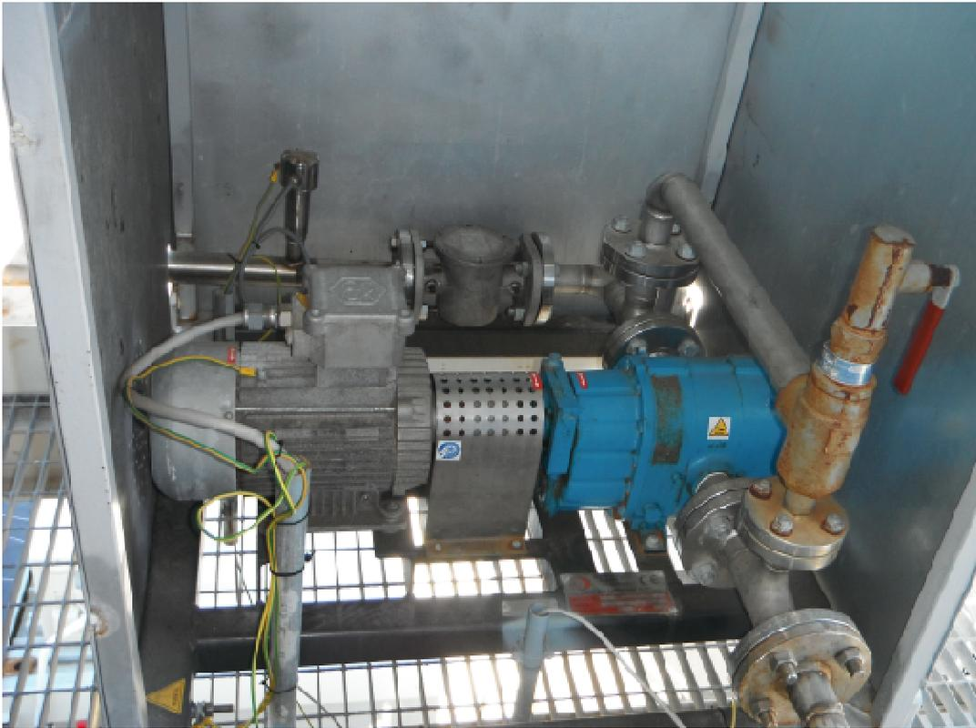
*Figura 2.6.2.1: Nuovo compressore a servizio della sezione di trattamento a caldo*
