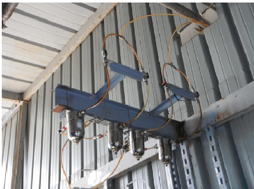
Figura 2.5.2.2: Elementi filtranti installati nel sistema di campionamento degli analizzatori O<sub>2</sub>
