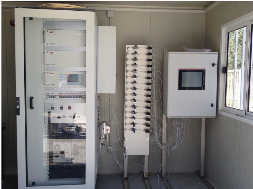
Figura 10 – Sistema di analisi online del syngas
