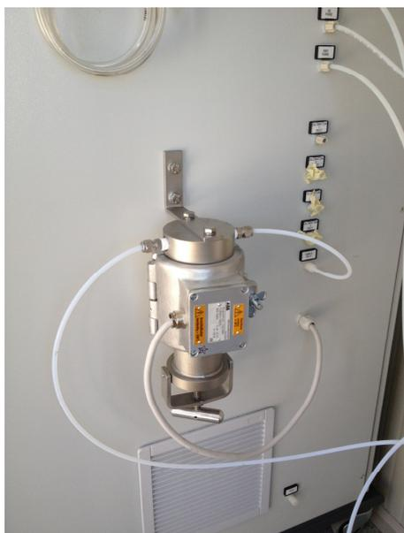
Figura 7 – Filtro per il trattamento gas
