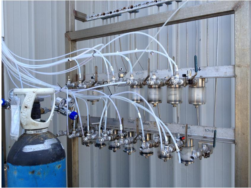
*Figura 1 – Rastrelliera di raccordo linee di campionamento*
