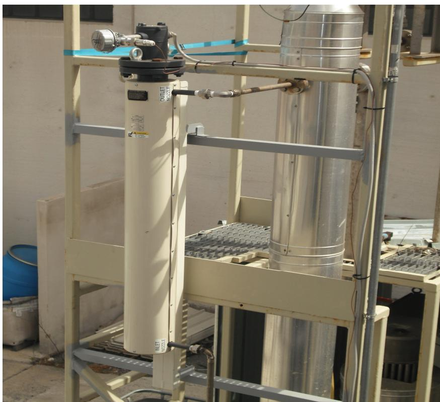
Figura 2.5.1: scambiatore elettrico preriscaldamento ammine
