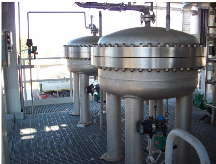
Figura 2.3. Reattori di assorbimento dell'anidride carbonica.
