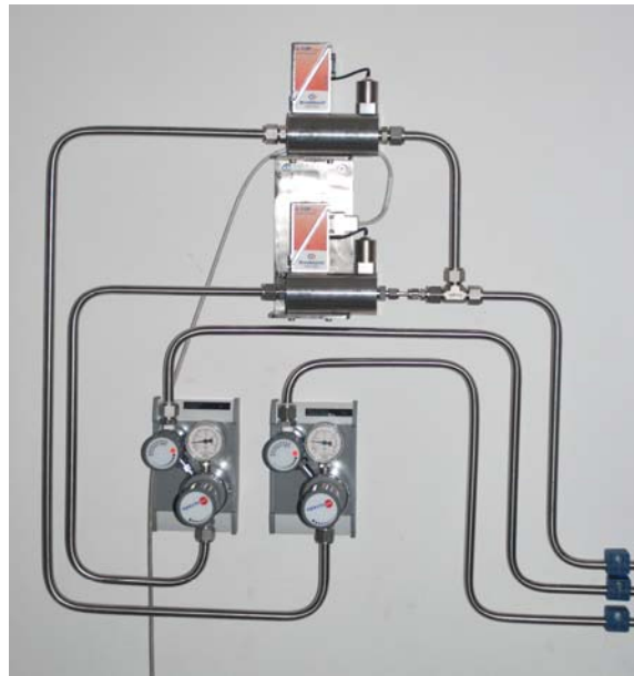
Figura 2.6. Riduttori di pressione di secondo stadio e regolatori di portata massica.
