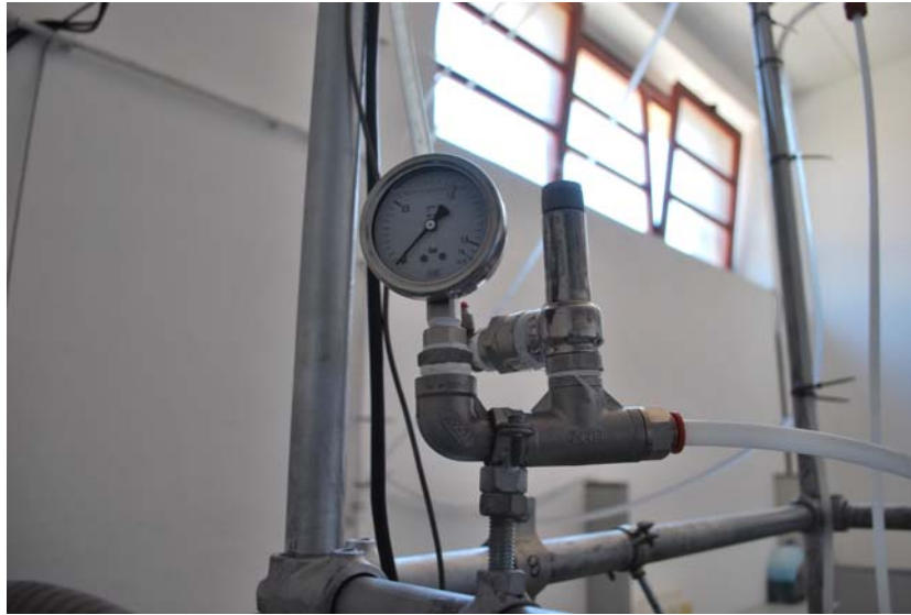
Figura 2.13. Manometro e valvola di sicurezza.
