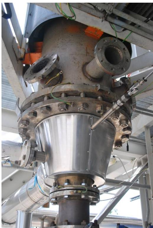
Figura 2.1. La parte inferiore del gassificatore pilota.
