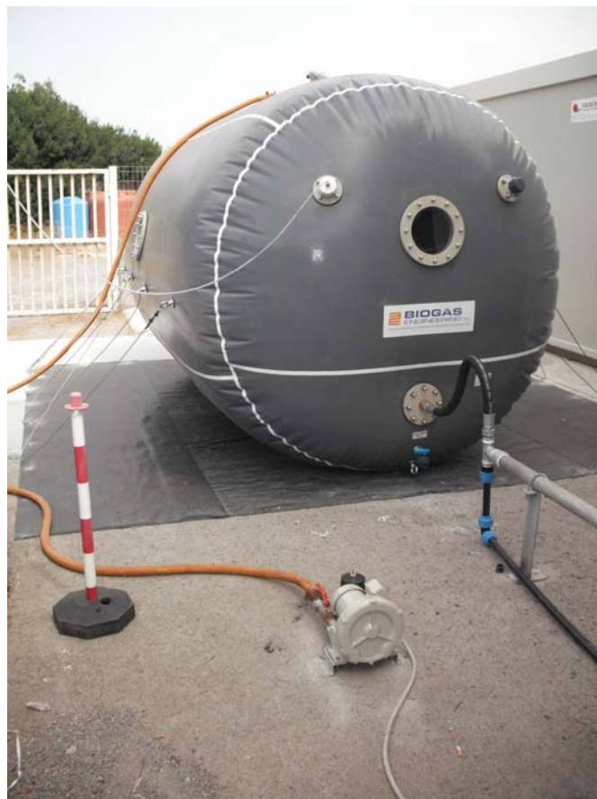
Fig. 2.2 Gasometro nell'impianto pilota
