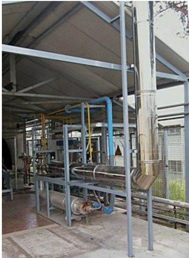
Figura 5: Sistema di evacuazione dei fumi.
