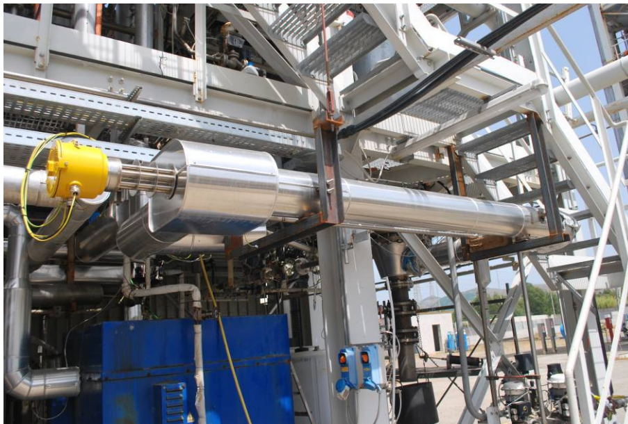
Figura 2.2. Sistema di riscaldamento degli agenti gassificanti.
