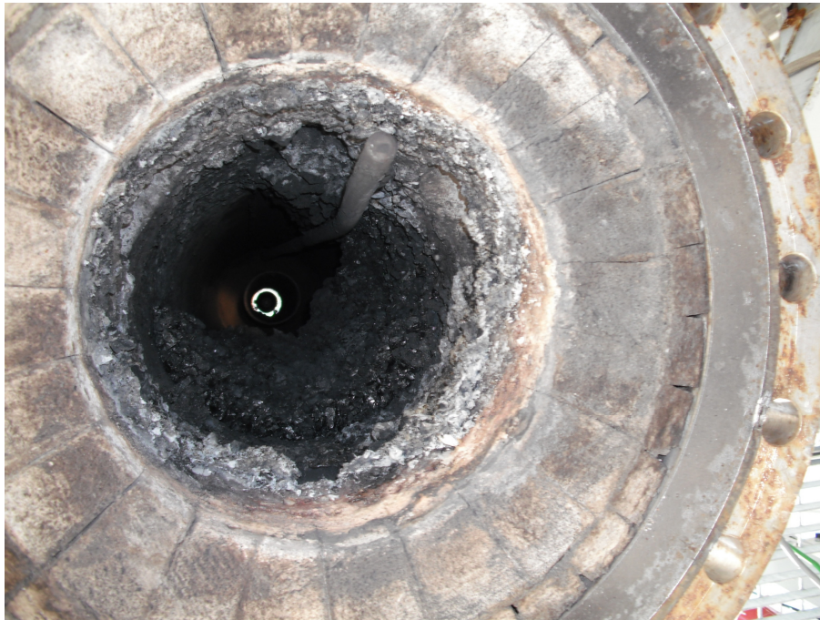
Figura 2.3.1 .refrattario pareti interne del gassificatore
