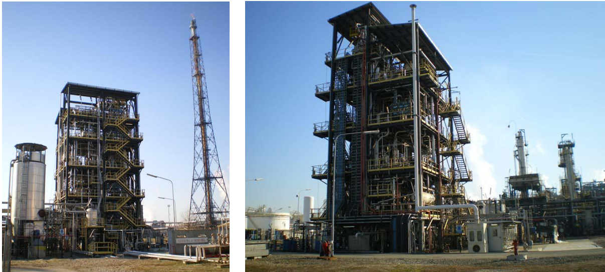
Figura 1.2: Impianto pilota Fischer-Tropsch di Eni
