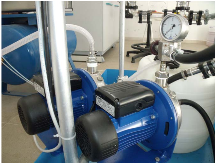
Figura 2.6. Sistema di rilancio del solvente in colonna.
