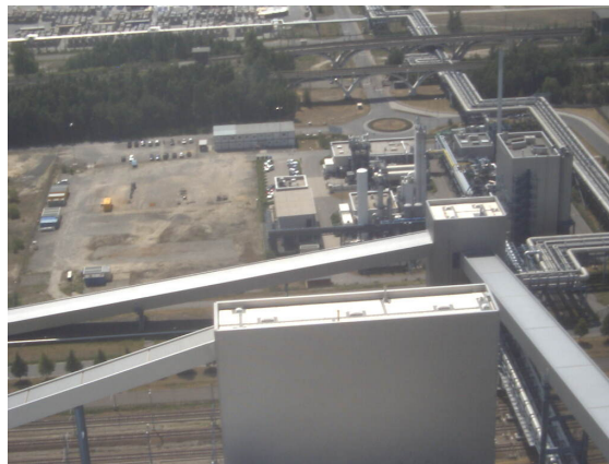
Figura 9.5. Impianto pilota da 30 MW presso la centrale Vattenfall di Schwarze Pumpe 111 .
