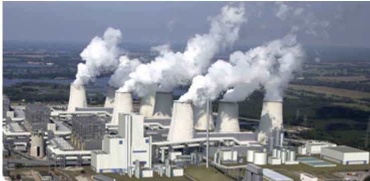
Figura 9.6. La centrale Vattenfall di Jämschalde 112 .
