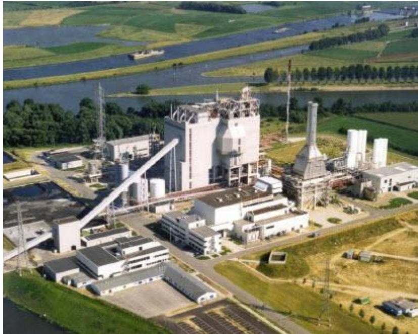
Figura 4.16. Impianto IGCC Nuon Power di Buggenum 37 .
