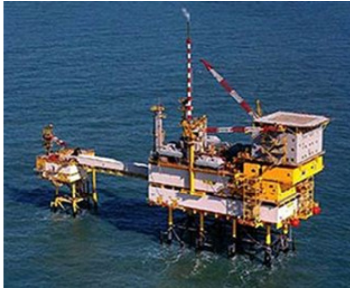
Figura 8.10. Piattaforma di estrazione e iniezione del giacimento K12-B nel mare del Nord 89 .
