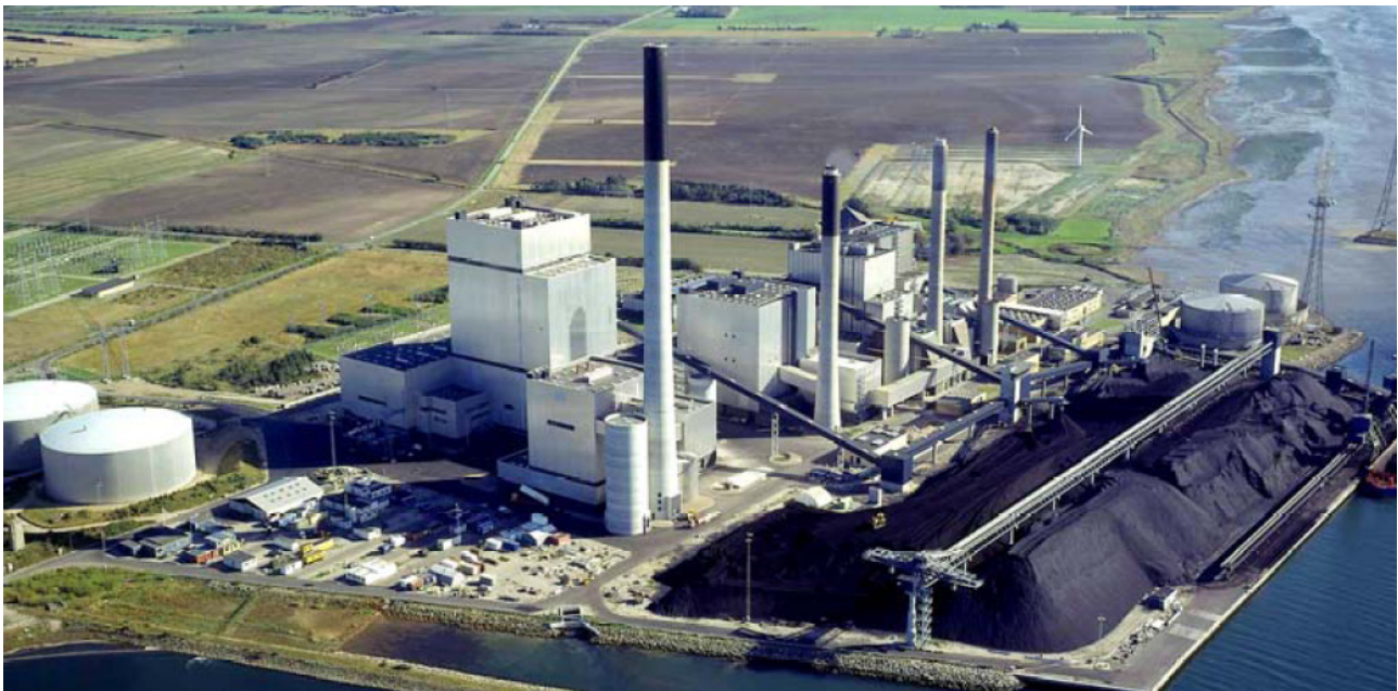
Figura 4.7. Impianto ultrasupercritico Nordjyllandsværket unit 3 21 .
