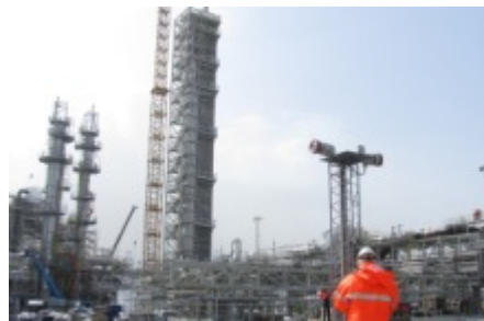
Figura 9.7. L'impianto di Mongstad, in corso di costruzione 115 .
