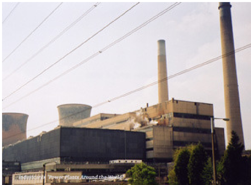
Figura 4.3 Impianto supercritico della PowerGen plc presso Drakelow, nel Regno Unito 14 .
