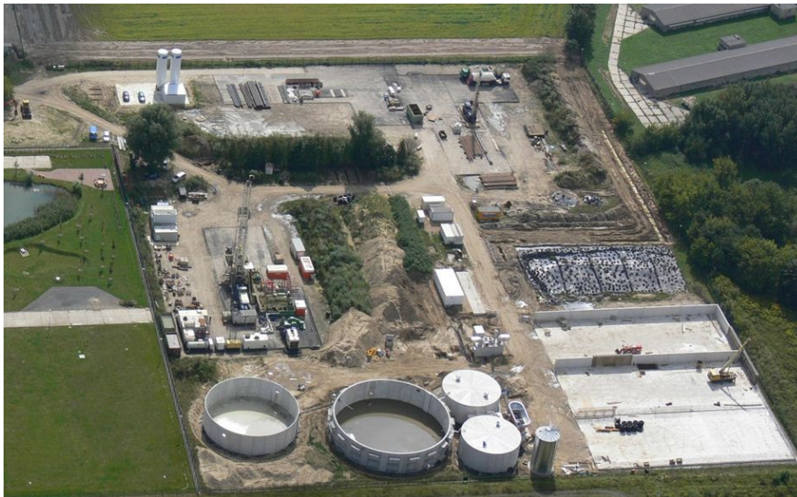
Figura 8.14. Il sito di confinamento di Ketzin, in Germania 94 .
