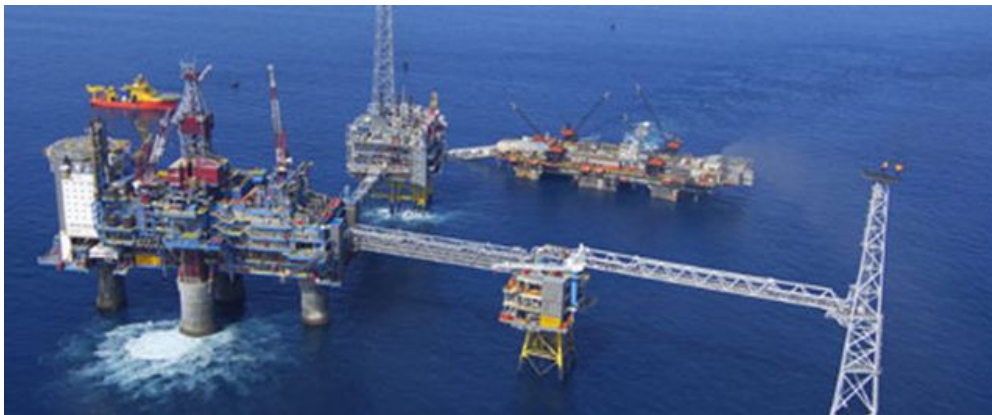
Figura 8.12. La piattaforma di estrazione di metano di Sleipner, nel mare del Nord 91 .
