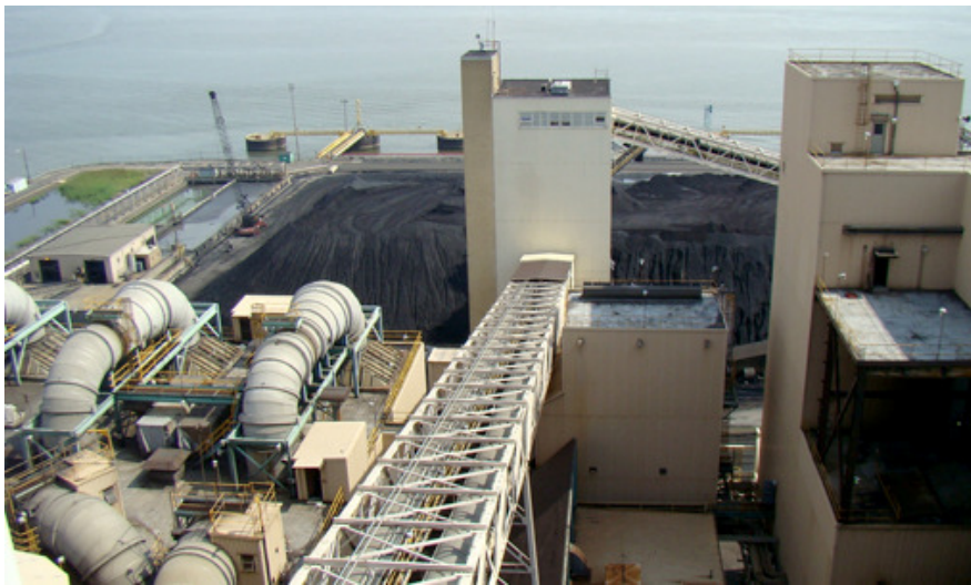
Figura 4.2 Impianto supercritico Eddystone Unit 2 della Exelon Corporation, negli Stati Uniti 13 .
