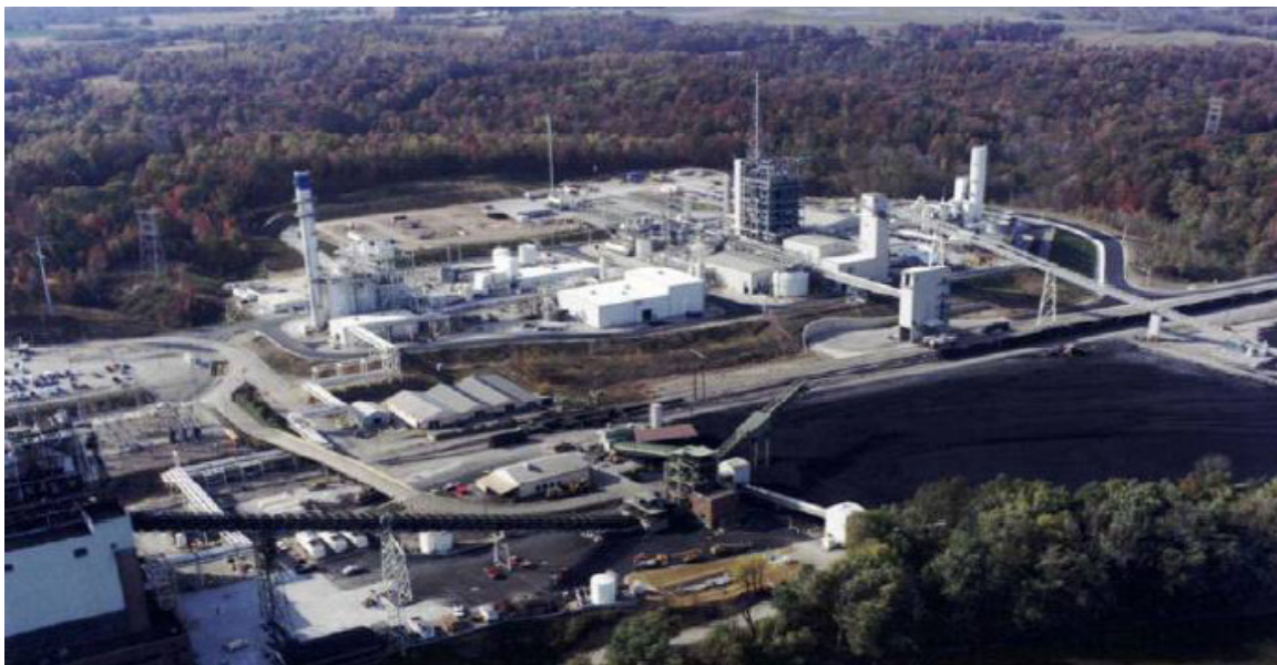
Figura 4.17. Impianto IGCC di Wabash River 38 .
