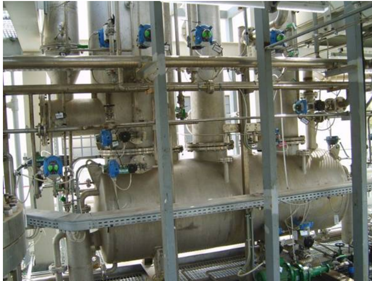
Fig. 3 - Sezione di clean up monitorata
