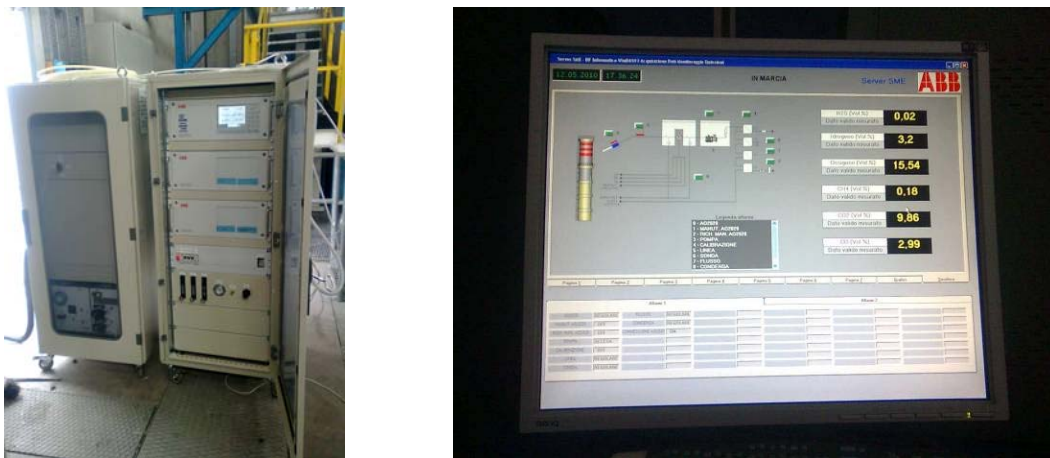
Fig. 6: Analitica modulare e sinottico di interfaccia con l'operatore
