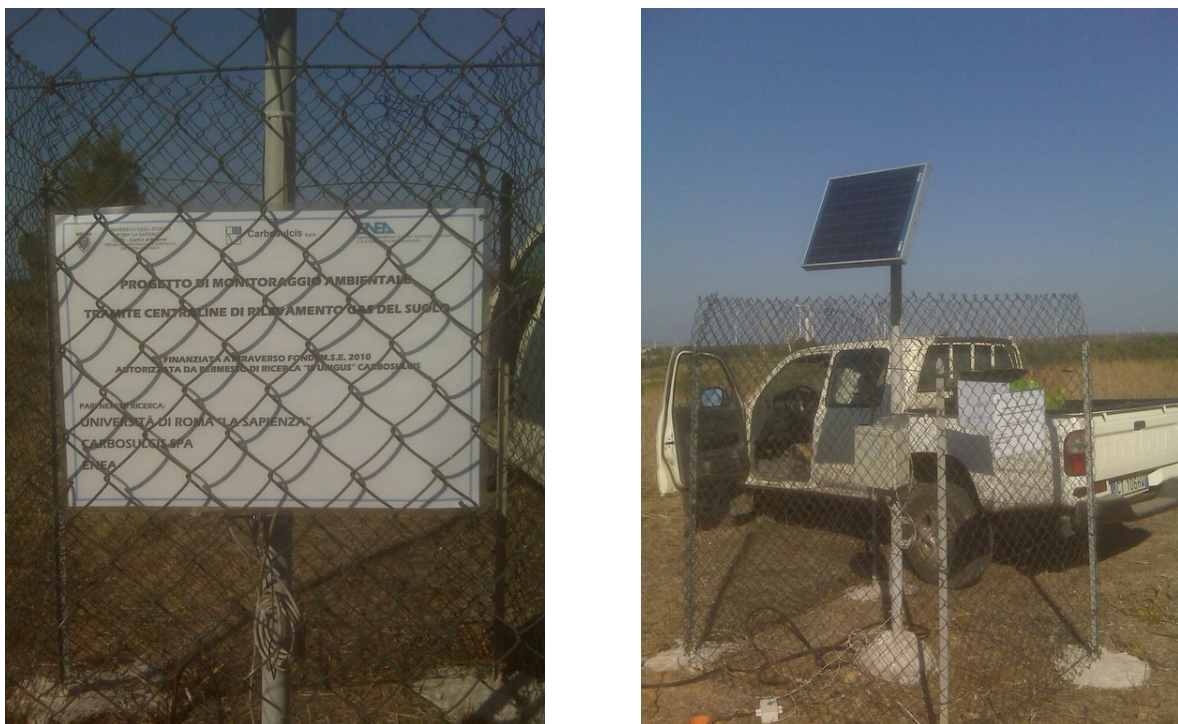
Figura 13. Installazione finale del sistema avvenuta ad agosto 2011.
