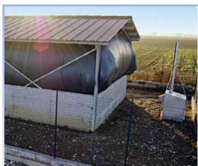
Figura 7 – Gasometro a torre.
