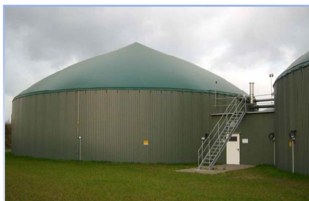
Figura 4 - Esempio di reattore CSTR
