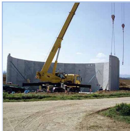
Costruzione di un digestore con manufatti prefabbricati e precoibentati
