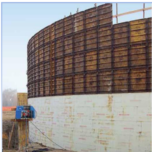
Costruzione di un digestore in opera con l'utilizzo di speciali casseri metallici
