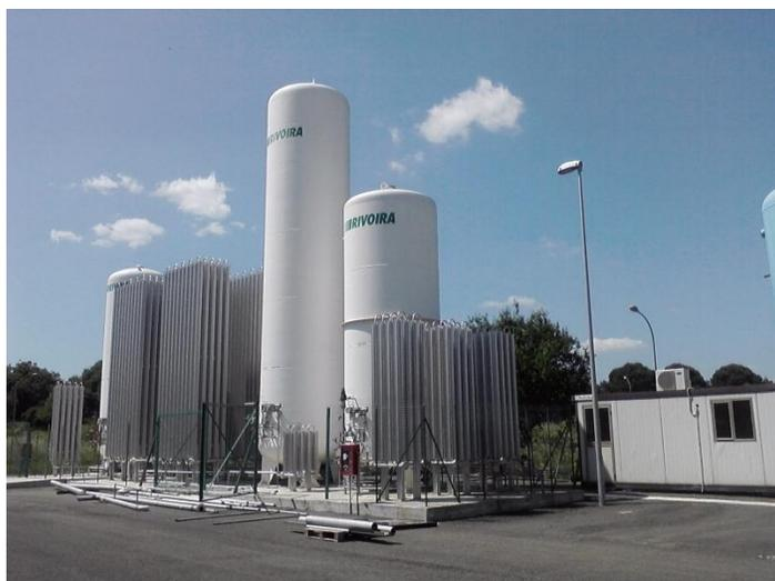
**Figura 1** Piazzola di stoccaggio serbatoi criogenici (azoto-ossigeno, anidride carbonica)
