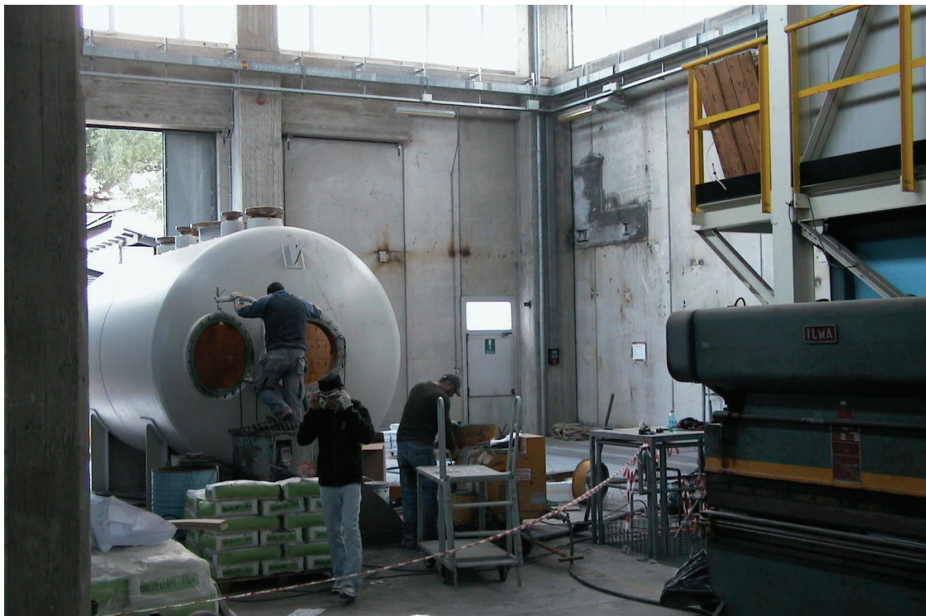
Figura 14: Fasi coibentazione con materiale refrattario in polvere
