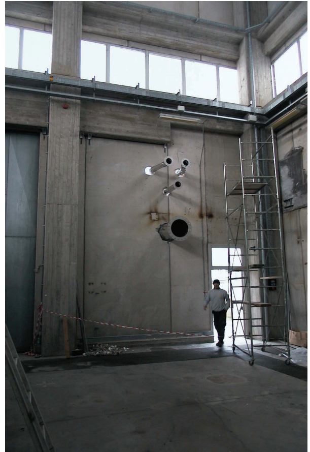
Figura 18: connessioni camino attraverso la parete
