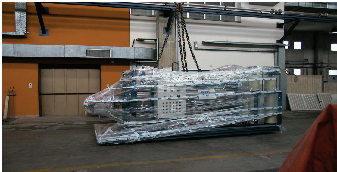
Figura 19: Installazione del generatore di vapore
