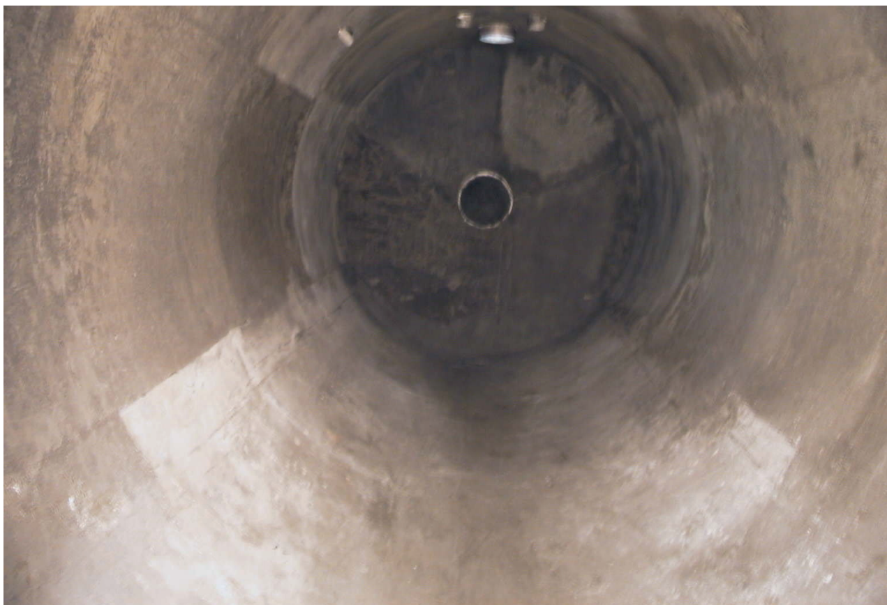
Figura 16: Fine coibentazione interna
