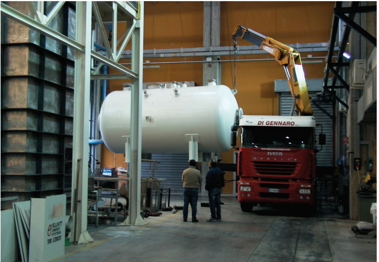
Figura 12: Fasi di scarico del vessel
