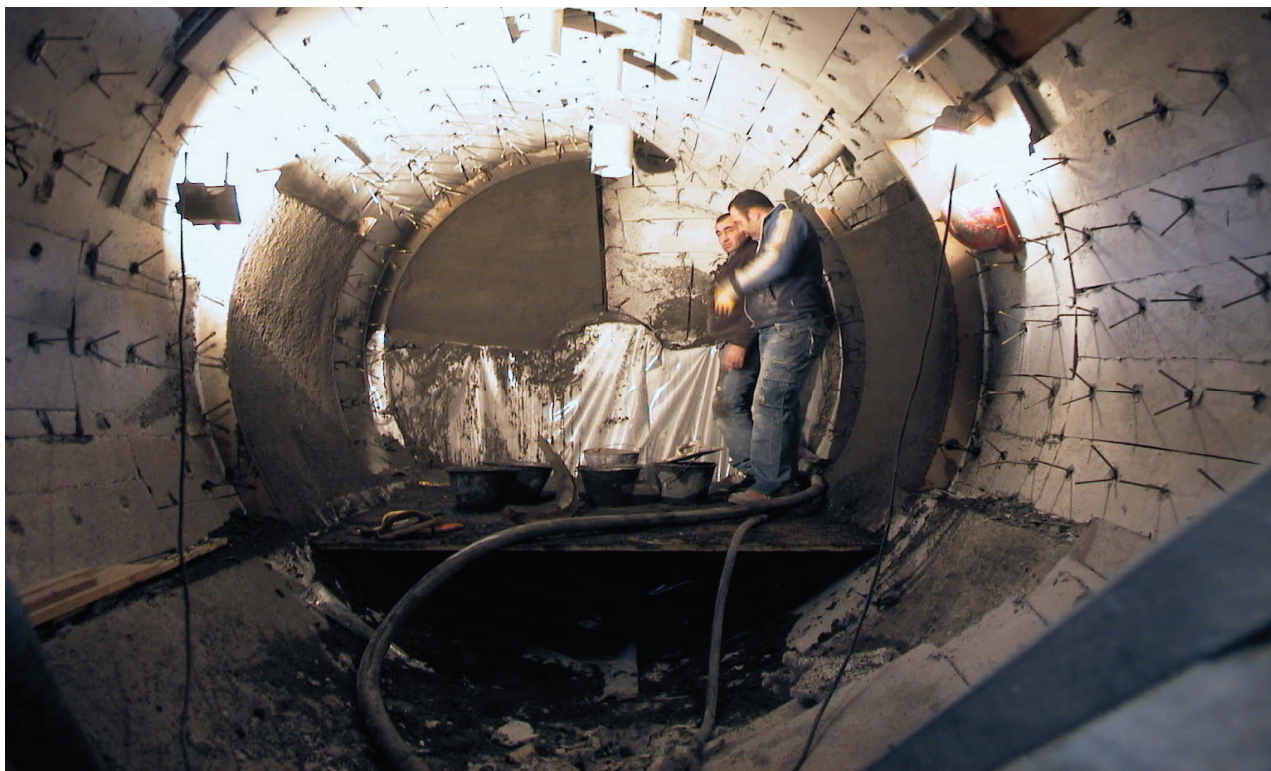
Figura 15: corso d'opera dell'attività di coibentazione
