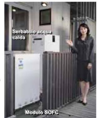
Unità da 1 kW per cogenerazione Kyocera/Osaka Gas
