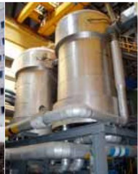
Stack PAFC da 670 kW
