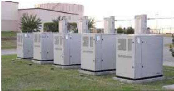
Unità GenSys 5 kW installate presso la base dell'Air Force di Robins (Georgia, USA)
