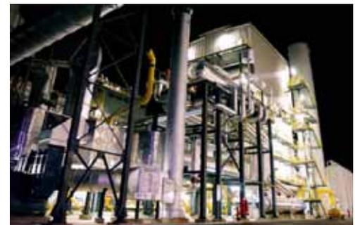
Impianto di steam reforming realizzato dalla Linde (Milazzo, Italia) - Capacità produttiva 65.000 Nm<sup>3</sup>/h
