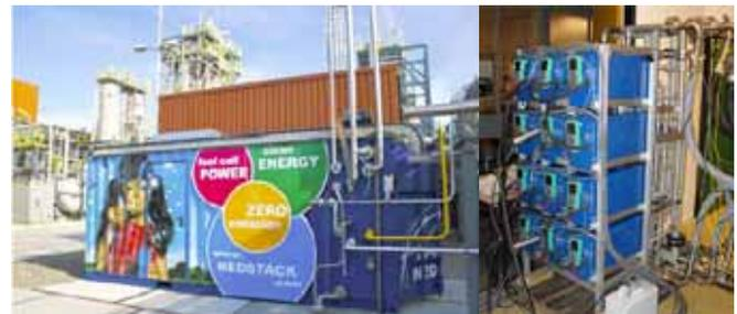
Impianto pilota installato da 50 kW presso la Akzo Nobel e modulo PEFC (12 stack da 10 kW)
