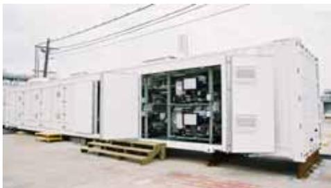
Moduli PEFC (300 kW) installati presso la Dow Chemical di Freeport, Texas
