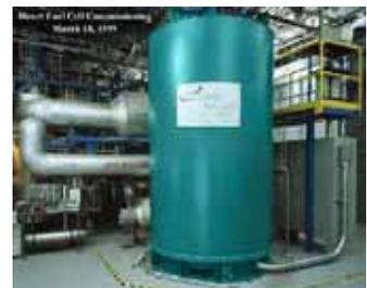
Impianto Direct Fuel Cell da 250 kW
