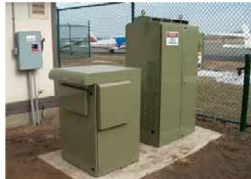
Unità GenCore e modulo di accumulo idrogeno
