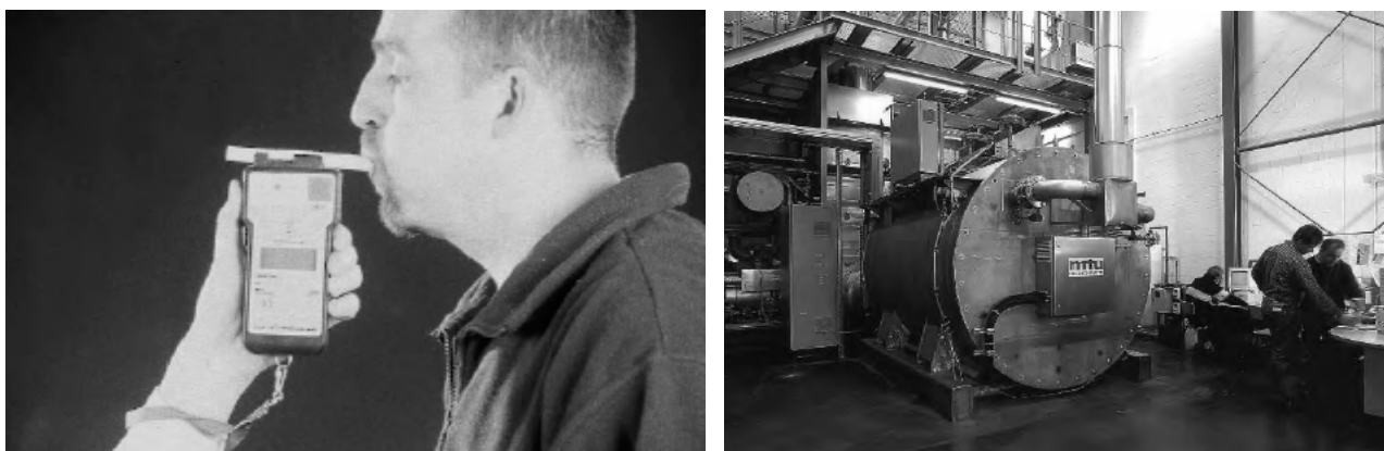
Figura 1 - a) Breath analyser alimentato da una cella a combustibile di tipo PEM ( Polymer Electrolyte Membrane ) usato dalla polizia per i controlli stradali. b) Sistema di cogenerazione progettato per l'ospedale di Bielefeld (GER) utilizzando uno stack MCFC ( Molten Carbonate Fuel Cell ) di 292 celle per una potenza complessiva di 280 kW.
