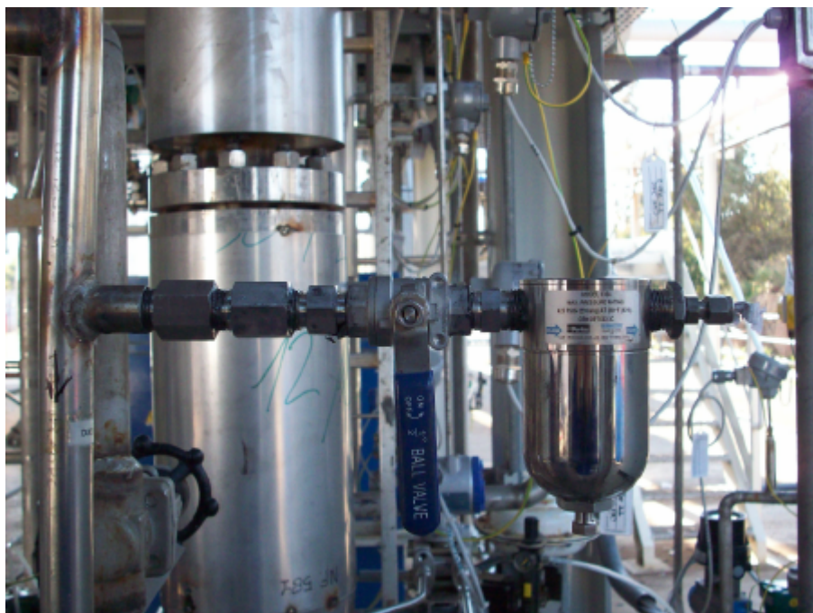
Preso di campionamento del syngas con sistema di condizionamento
