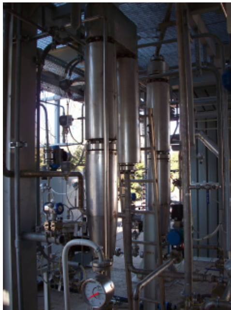
Figura 12: reattori di CO-shift
