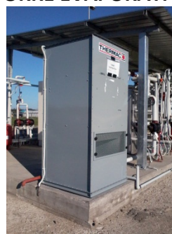
FIGURA 62: Caratteristiche principali delle apparecchiature nel funzionamento invernale
